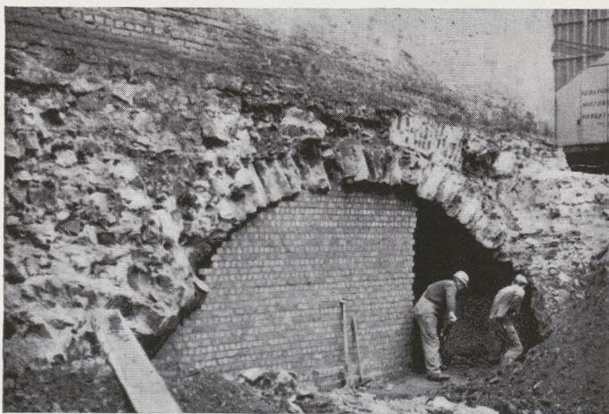
FIG. 13. — La Tour aux Lapins après démolition de la façade postérieure : section oblique de la voûte couvrant le chenal.
