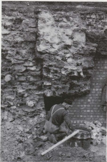
FIG. 7. — Boulevard d'Avroy, près de la Tour aux Lapins : section des fondations d'un pilier.
