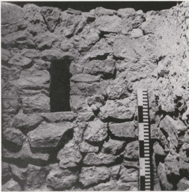
FIG. 29. — Extérieur de la fenêtre percée dans le mur est de la crypte (mur 121).
