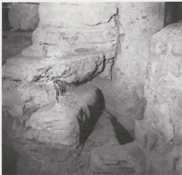
FIG. 18. — Escalier construit contre la colonne 48.
