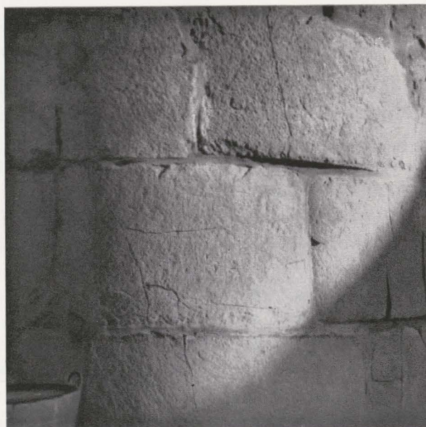
FIG. 40. — Partie inférieure de la tourelle d'escalier romane.
