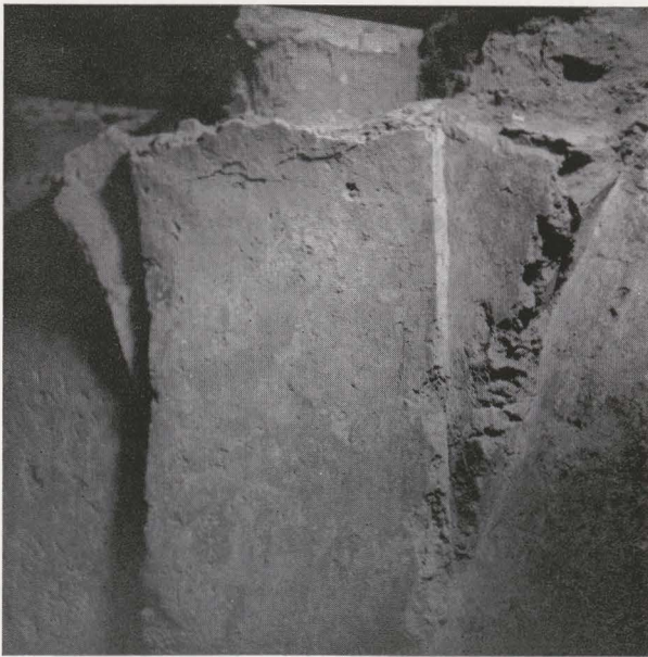
FIG. 30. — Pilastre dans le mur nord de la crypte, et départ des arêtes de la voûte.
