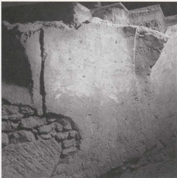
FIG. 31. — Pilastre dans le mur ouest de la crypte.
