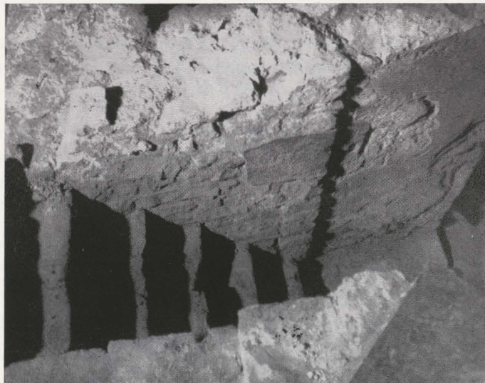
FIG. 32. — Entrée ouest de la crypte, avec escalier.
