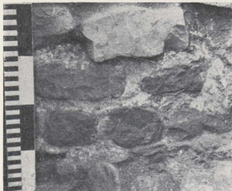
AFB. 18. - Westfundering van de zuidelijke transeptarm : ingewerkt ouder parement bestaande uit regelmatige blokjes Doornikse steen, gemetseld met roze mortel.
