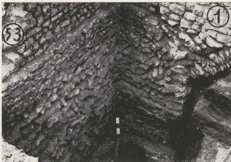
AFB. 5. — De fundering der muren 1 en 53.
