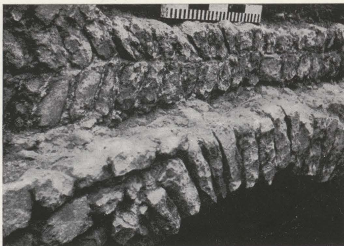
AFB. 7. — Detail van muur 1.
