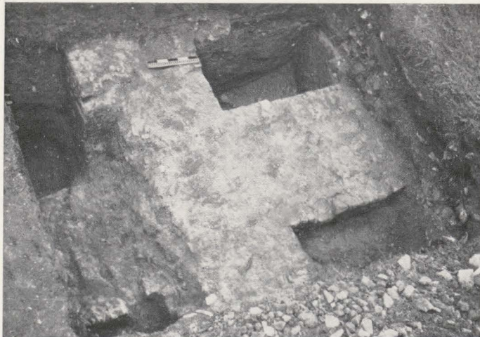
AFB. 20. — De verstevigde noordoostelijke vieringspijler (uit het oosten).
