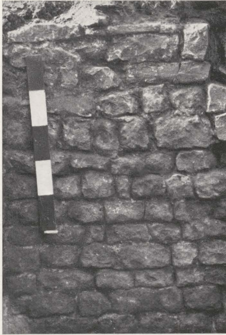
AFB. 19. — Detail van muur 30 in de noordwestelijke hoek van de noordelijke kruisbeukarm. De bovenste vier veldsteenlagen behoren tot het jonger metselwerk.
