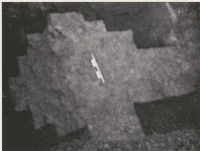
AFB. 12. — De noordoostelijke vieringspijler (uit het oosten gezien).
