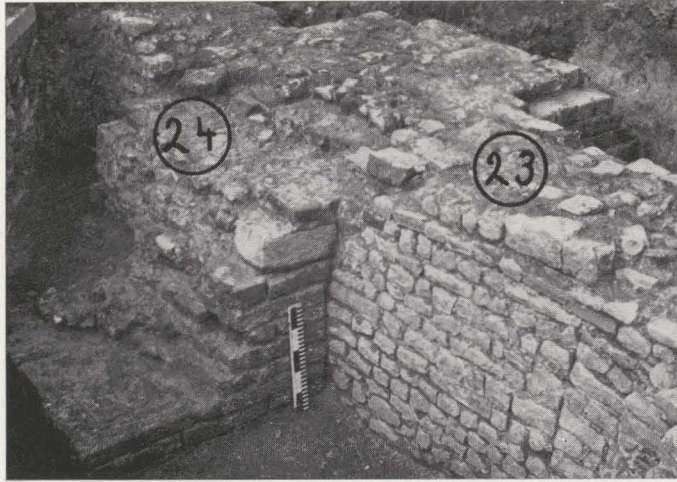
AFB. 28. — Gotische pijler 24 tegen en boven de romaanse muur 23 (uit het zuidoosten).
