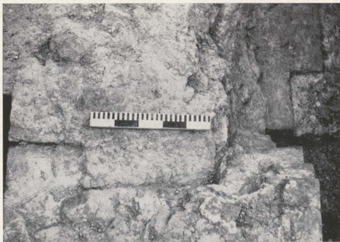
AFB. 13. — Detail van de noordoostelijke vieringspijler.
