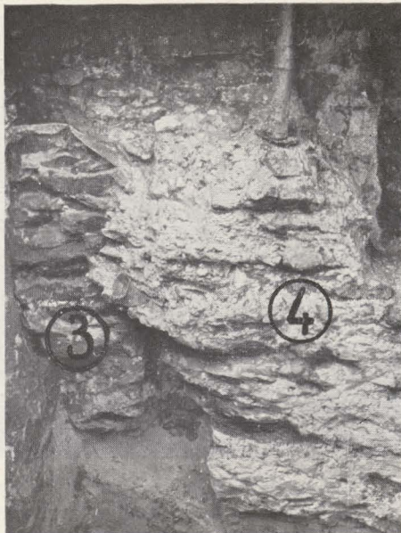
FIG. 15. — 3 : Fundering van de zuidelijke pijler van de triomfboog van kerk I. — 4 : Jongere fundering van de oostelijke vieringsboog van kerk II.
