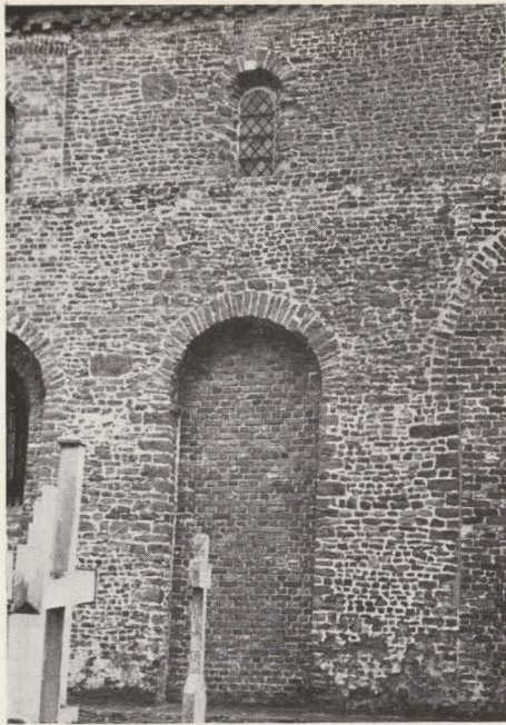
FIG. 14. — Tweede travee van de noordmuur van de middenbeuk. De pijler links is gedeeltelijk hersteld met te grote veldsteen. De eerste travee is herbouwd in de gotiek; daarvan ziet men de aanzet van de scheiboo. Een barokvenster had het derde romaans bovenlicht vervangen; het is nu terug aangebracht.
