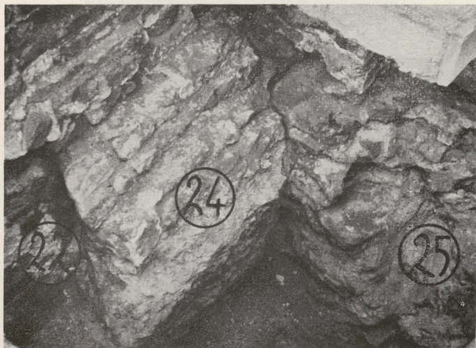
FIG. 13. — Tegenaan de oude fundering 25, de fundering van de oostmuur van de noordelijke kruisbeukarm 24; door het graf 22 werd een gedeelte van 24 uitgebroken (zie afb. 6).
