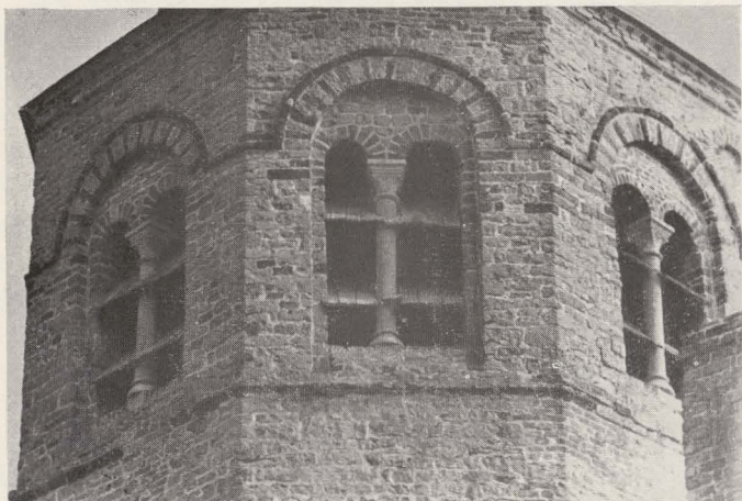
FIG. 23. — Detail van de toren. De middenzuiltjes zijn nieuw, de gekoppelde boogjes zijn van tufsteen. In de afdekkingsbogen wisselt veld- en tufsteen af. (Foto J. Mertens).
