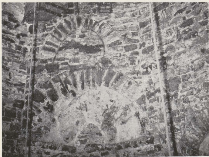
FIG. 17. — Toren, tromp en ontlastingsboog.
