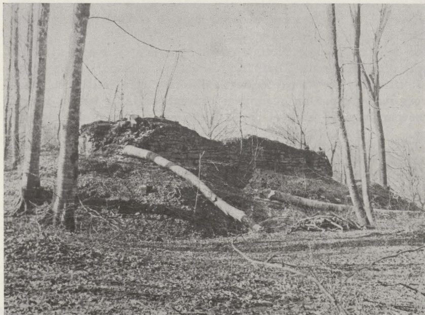
Fig. 7. — Les ruines de la tour, vues du Nord.
