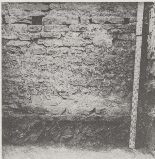
Fig. 8. — Les fondations du mur dans le rempart central.
