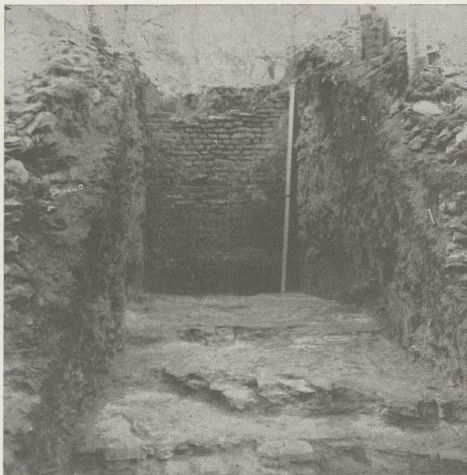
Fig. 9. — Tranchée I avec mur.
