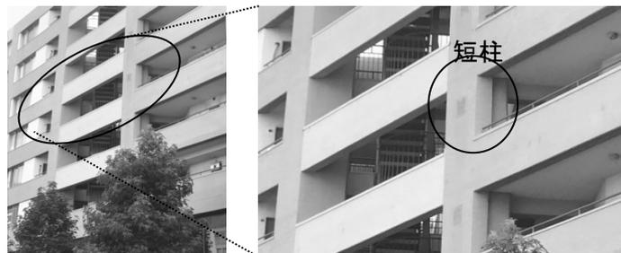
写真 1.2 1970 年後半の集合住宅の共用廊下の柱
