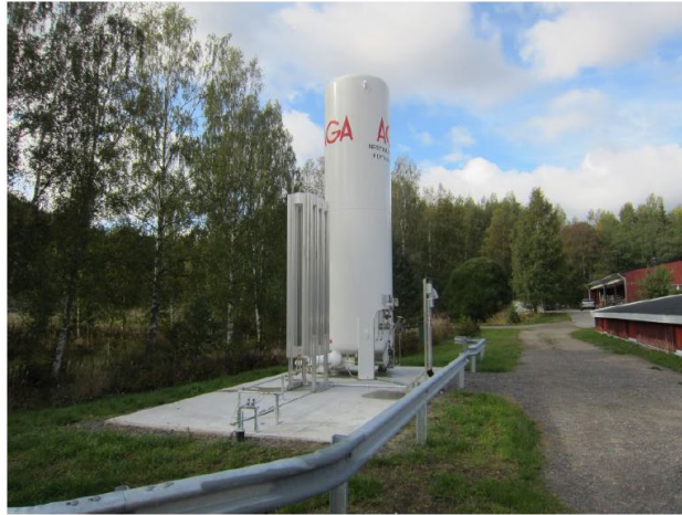
Kuva 2. Happi voidaan tuottaa paikallisesti generaattorilla tai tuoda nestehappena. Kuva: Martti Naukkarinen.
