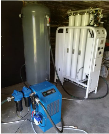
Kuva 2. Happi voidaan tuottaa paikallisesti generaattorilla tai tuoda nestehappena. Kuva: Martti Naukkarinen.
