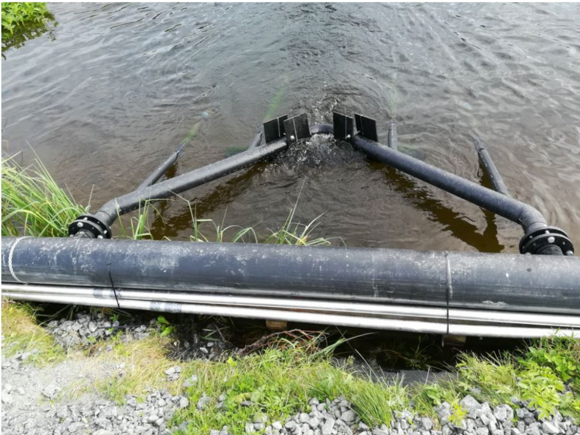
Happivesi suuttimista tulovirtaukseen sekoittaen
