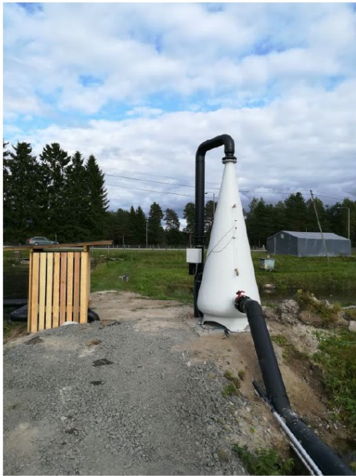
Kuva 3. Happi voidaan liuottaa paineistetussa tilassa tai valuttamalla. Kuva: Martti Naukkarinen.
