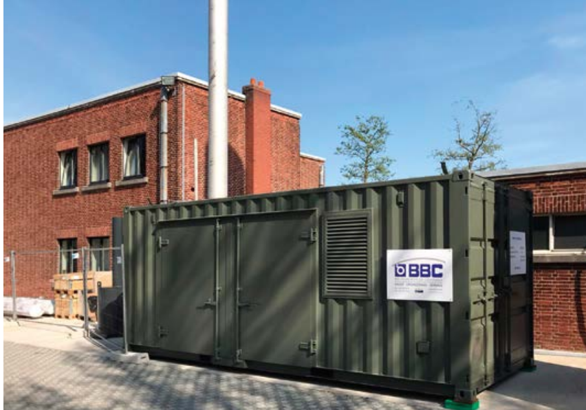
Stoomketelunit in standaardcontainer. (Foto : BBC Loos)
