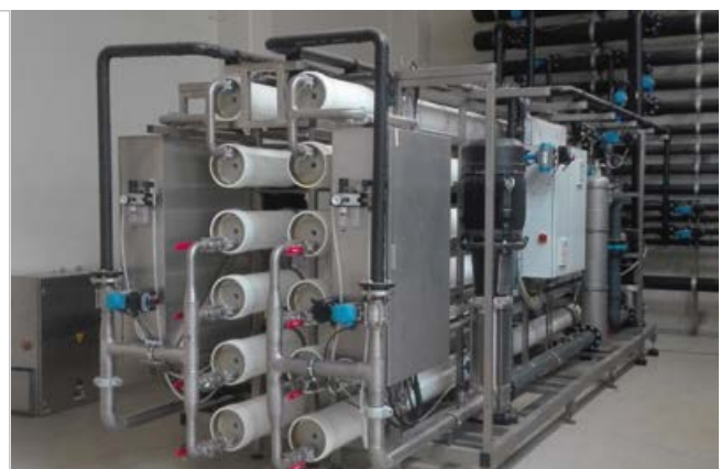
Figuur 3: Omgekeerde osmose (RO) bij een groenteverwerker die MBR-effluent recupereert en toepast voor stoom en koeling. (Foto : Hydris)
