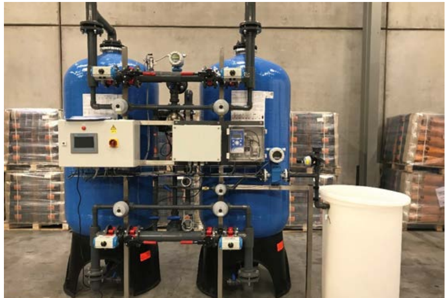
Figuur 1: Upflow ontharder met verhoogde water- en zoutefficiëntie voor verlaagde operationele kosten en minder lozing van chloriden. (Foto : Hydris)
