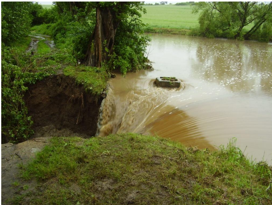
Obrázek 5 - Protržená hráz rybníku Linhart (mjr. Ing. Jarmil Soukup, www.hzscr.cz )
