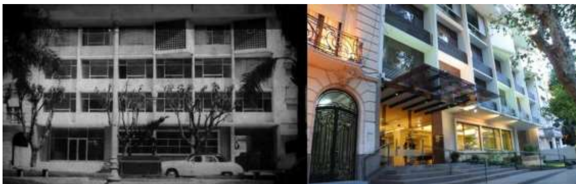
Imagen 5: Fachada Sanatorio Parque 1953-2015
