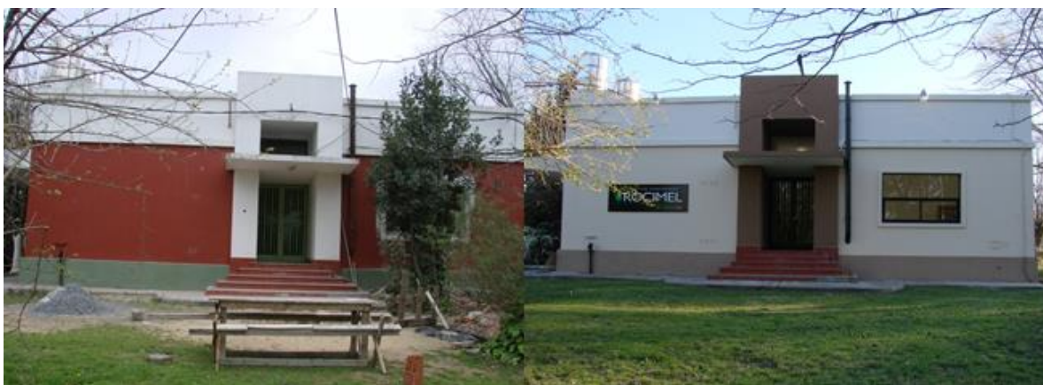
Panel 9: Frente de la empresa Rocimel antes (izquierda) y después de las obras de remodelación (derecha)
