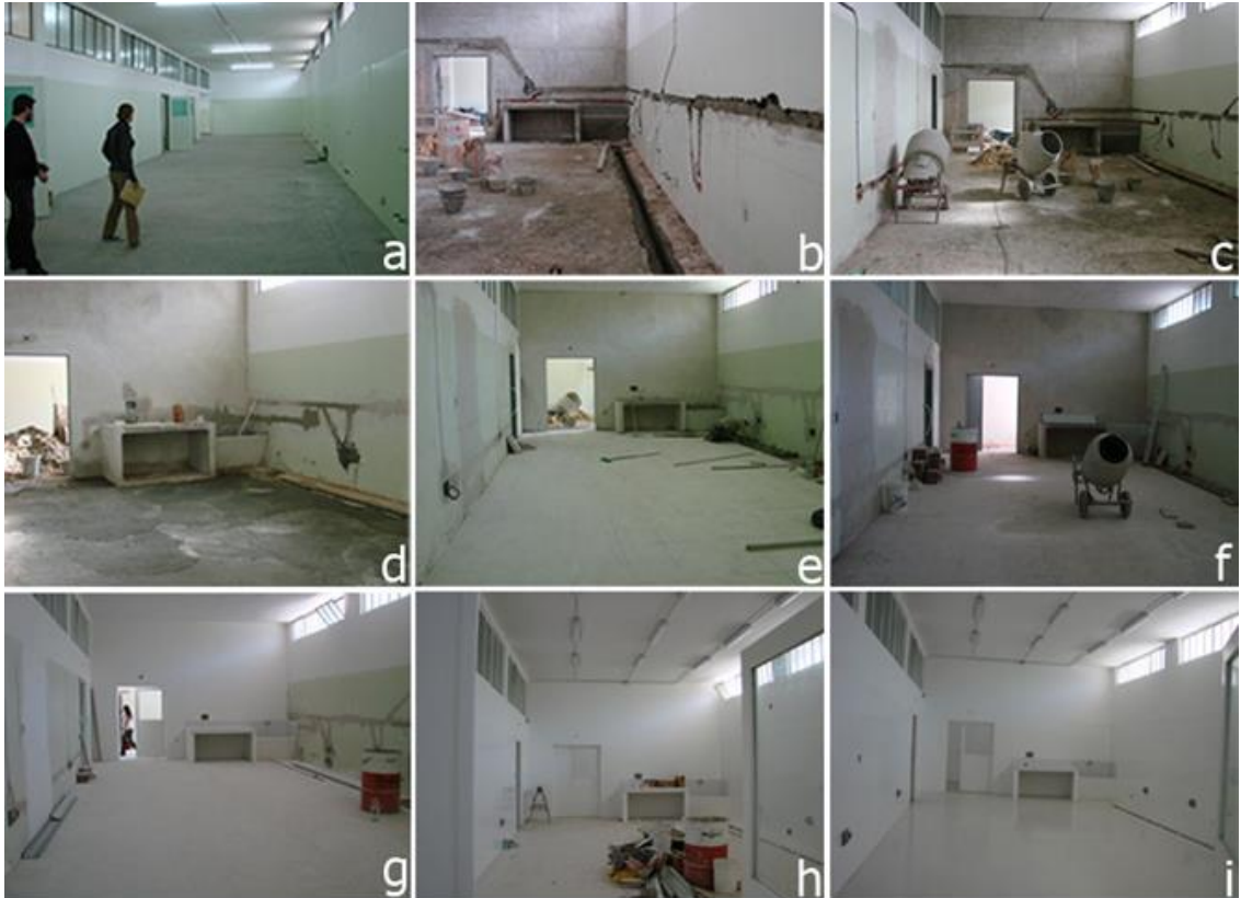
Panel 7: Fotos ilustrativas del avance de las obras realizadas en un sector de la empresa Rocimel. a: estado del Galpón al momento de la adquisición, b: inicio de las obras de remodelación, c-h avance de obra, i: los sectores de Rocimel quedaron totalmente renovados en sus pisos, paredes, servicios, etc., como se puede observar en las fotografías.
