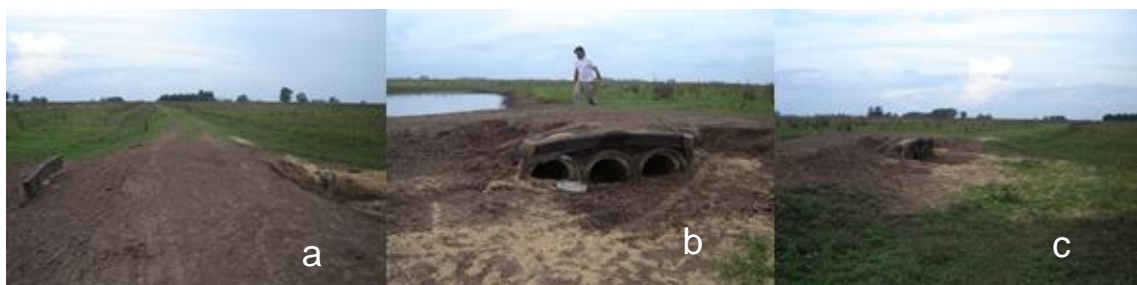
Panel 3: Fotos ilustrativas de los caminos hechos en el interior del campo. En los casos de las fotos b y c se puede ver también los desagües que se realizaron para atravesar pequeñas lagunas.
