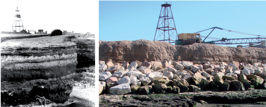
Figura 13. Farola de Punta Hermengo (Miramar, Partido de General Alvarado). Izquierda fotografía tomada en el año 1982 (E. P. Tonni) donde puede observarse la distancia de la farola al acantilado; Derecha: fotografía tomada en el año 2007 (E. Soibelzon), luego de que el municipio dispusiera bloques de cuarcita para evitar la retracción natural de los acantilados, impidiendo así el acceso a los niveles basales de esta clásica localidad paleontológica (ver detalles en Cenizo et al. , 2011).
