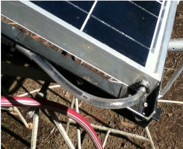
Figura 5a: Detalle conexión entrada de agua.
