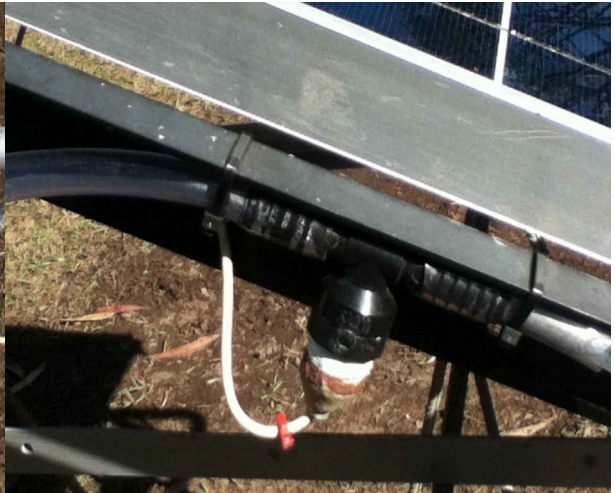
Figura 5b: Detalle sensor de temperatura.
