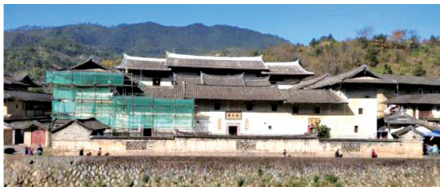
图1 修缮中的“福裕楼”(图片来源:作者自摄)
