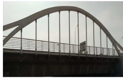
(a) 实桥照片
