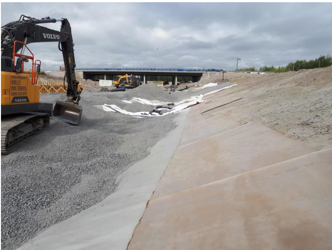
Kuva 18. Tutustumiskäynnillä käynnissä oleva työvaihe. Murskeen levitystä asennetun laminoitun bentoniittimatton, ojan pohjaan asennetun tiivistyskalvon ja suojageotekstiilin päälle. (Leppänen 2019)
