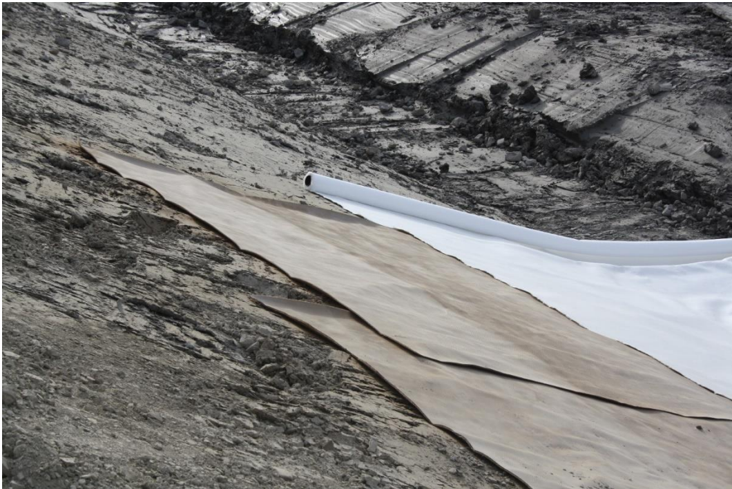
Kuva 20. Laminoidun bentoniittimaton limitys. (Leppänen 2019)
