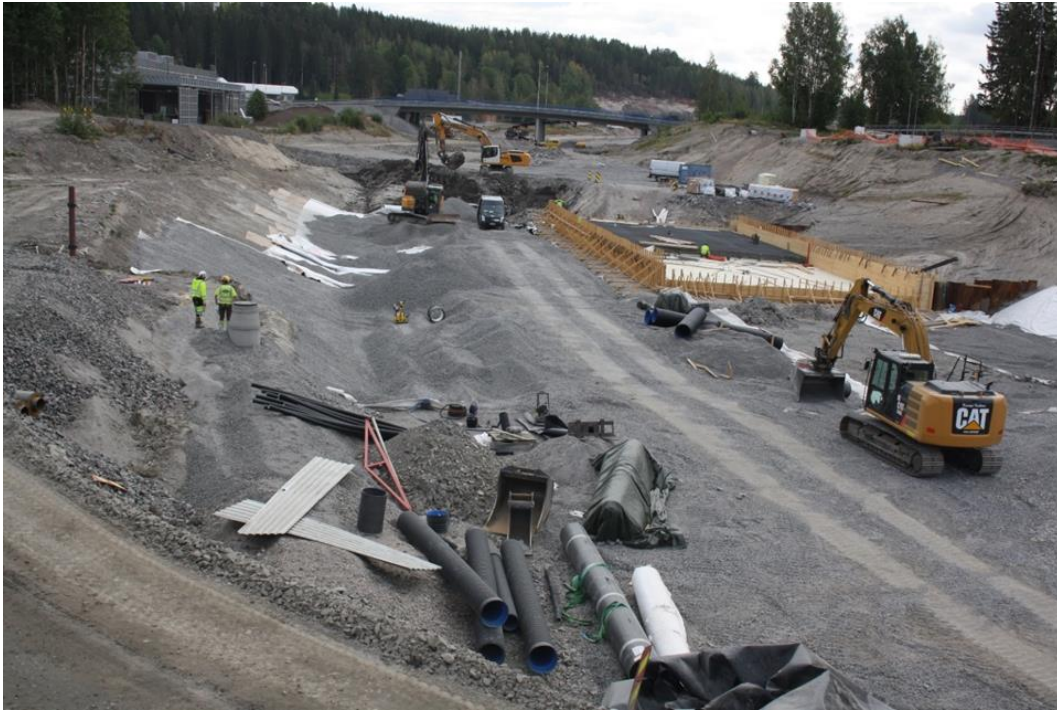
Kuva 17. Yleiskuva pohjavedensuojaustyömaasta. (Leppänen 2019)
