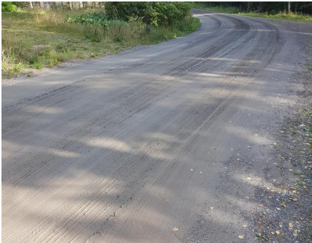
Kuva 10. Tien pinnassa olevaa lievää pintakelirikkoa kohteessa VII.
