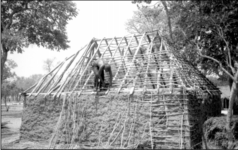
Abbildung 17: Hausbau in Nangweshi
