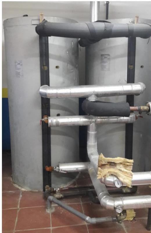
Figura 3. 5: Interacumuladores VITOCCEL de 1000 [l] instalados en la comunidad objeto
