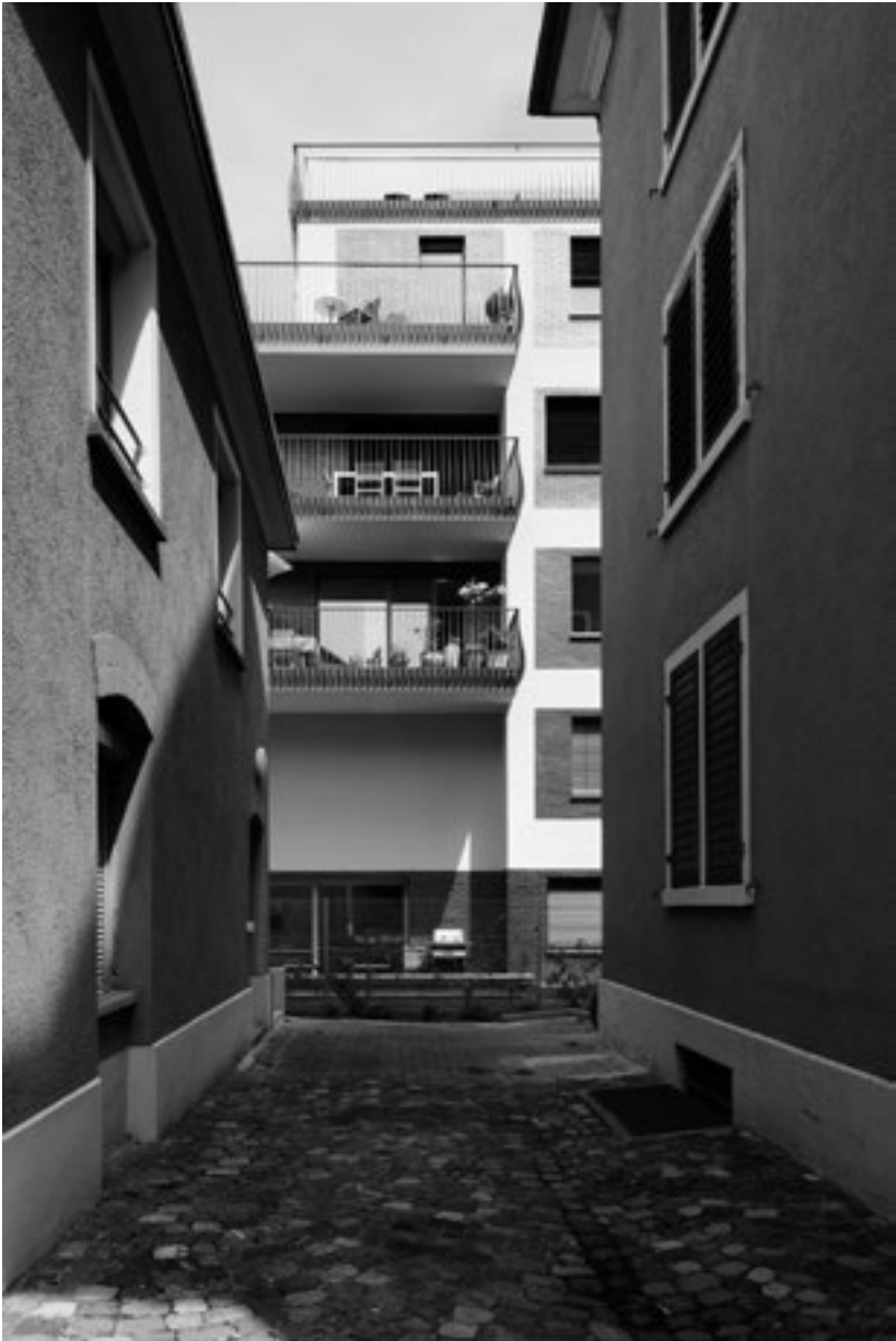
5 hbf, Stadthaus Waffenplatzstrasse, Durchsicht Hof Fotografie Beat Bühler, Zürich
