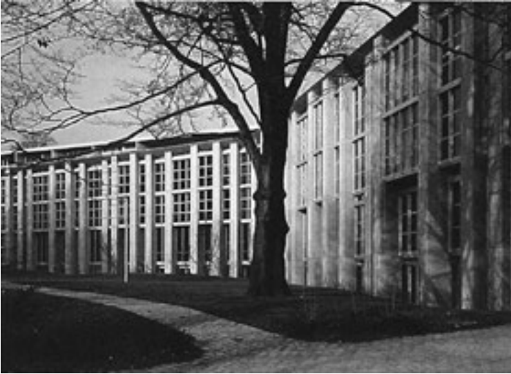
6 Eduard Neuenchwander: Kantonsschule Rämibühl, Zürich (1960–1970)
