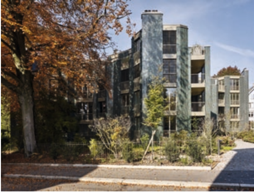
16 Wohnhaus Steinwiesstrasse, Zürich-Hottingen, 2011–2015
