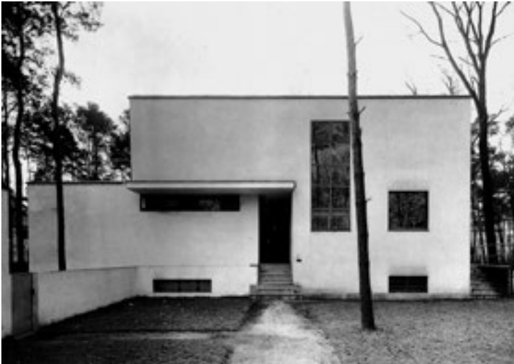
8 Walter Gropius, Direktorenwohnhaus am Bauhaus Dessau, 1925–26, Ansicht, Straßenseite
