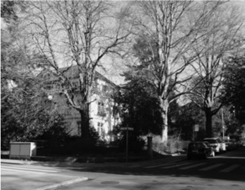
3 Platten-/Steinwiesstrasse in Zürich-Hottingen mit dem geschützten Baumbestand und dem zu ersetzenden Bestandsbau
