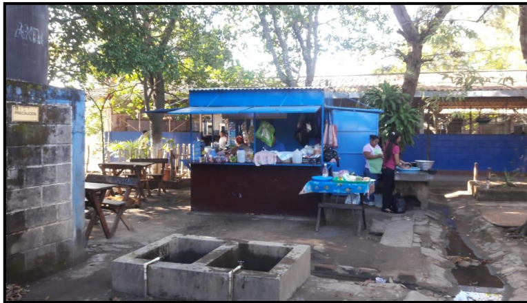
FIGURA 112. ESTADO ACTUAL DEL ÁREA DE CAFETÍN #1.
