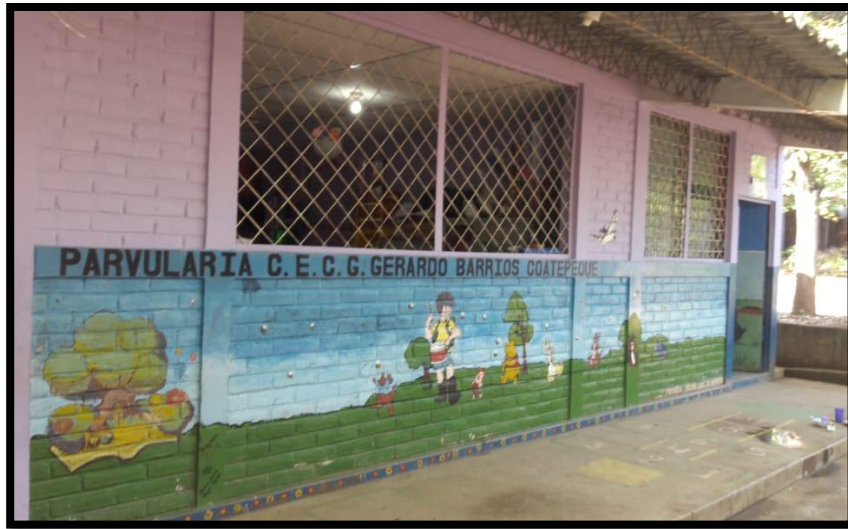
FIGURA 57. PANORÁMICA DE AULAS DE PARVULARIA.
