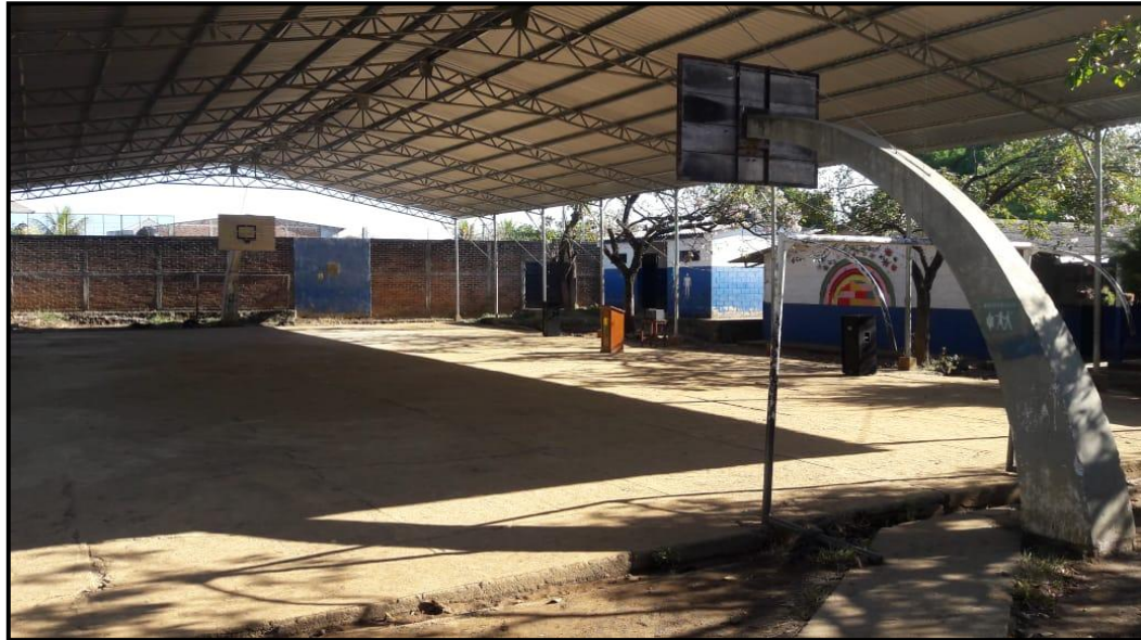
FIGURA 107. ESTADO ACTUAL DE ÁREA RECREATIVA, CANCHA DE BASQUETBOL, VISTA 1.
