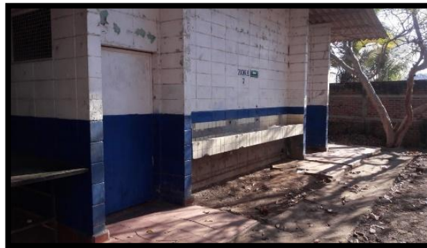
FIGURA 47. ESTADO ACTUAL DE PASILLO PRINCIPAL, BLOQUE #4.
