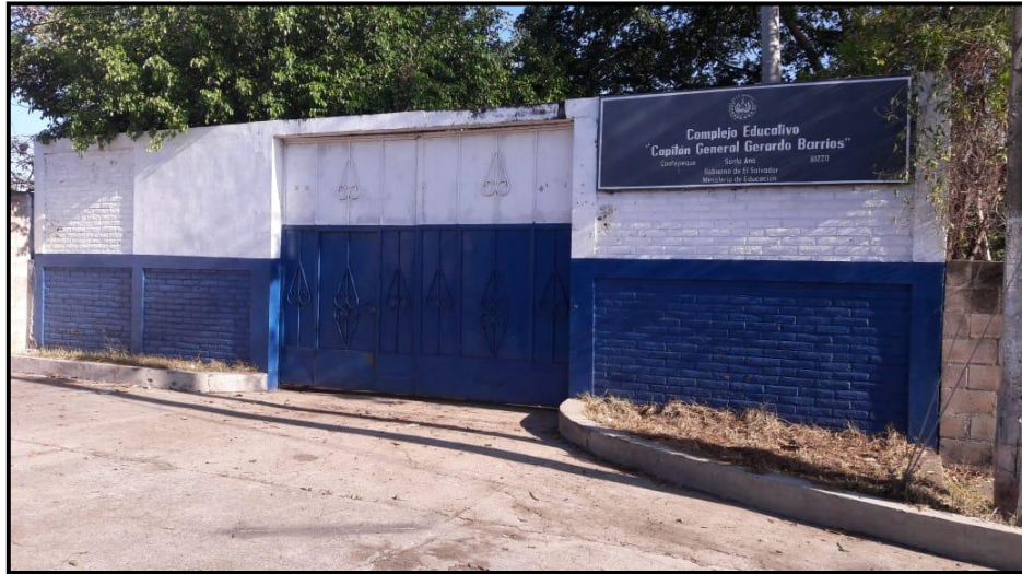
FIGURA 98. FACHADA ACTUAL Y ACCESO PRINCIPAL AL COMPLEJO EDUCATIVO.
