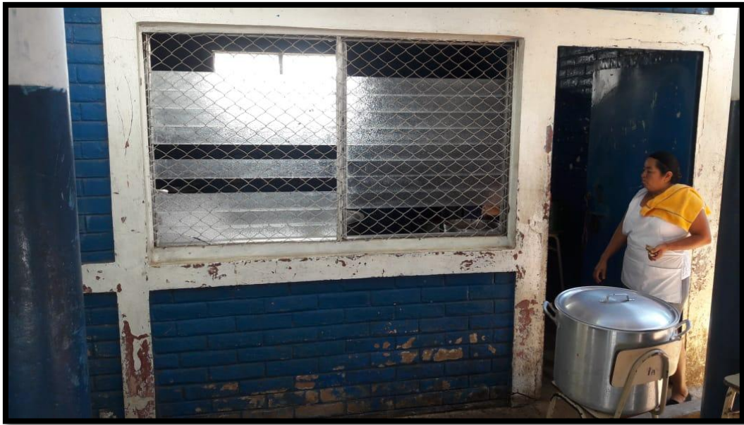
FIGURA 60. FACHADA DEL ÁREA DE COCINA.
