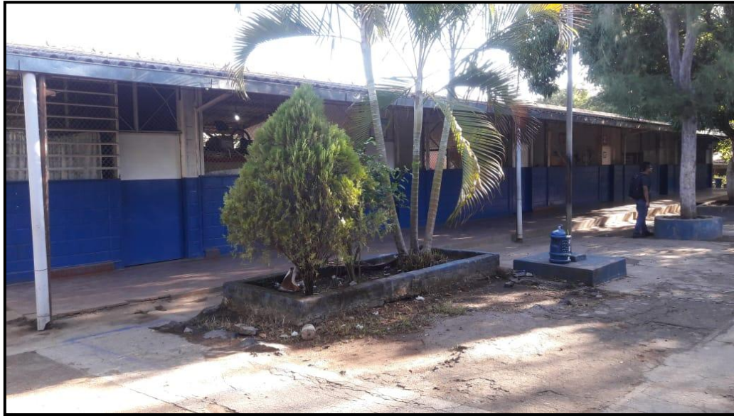
FIGURA 121. VISTA PANORÁMICA DEL ESTADO ACTUAL DE ARRIATES Y PABELLÓN #1.
