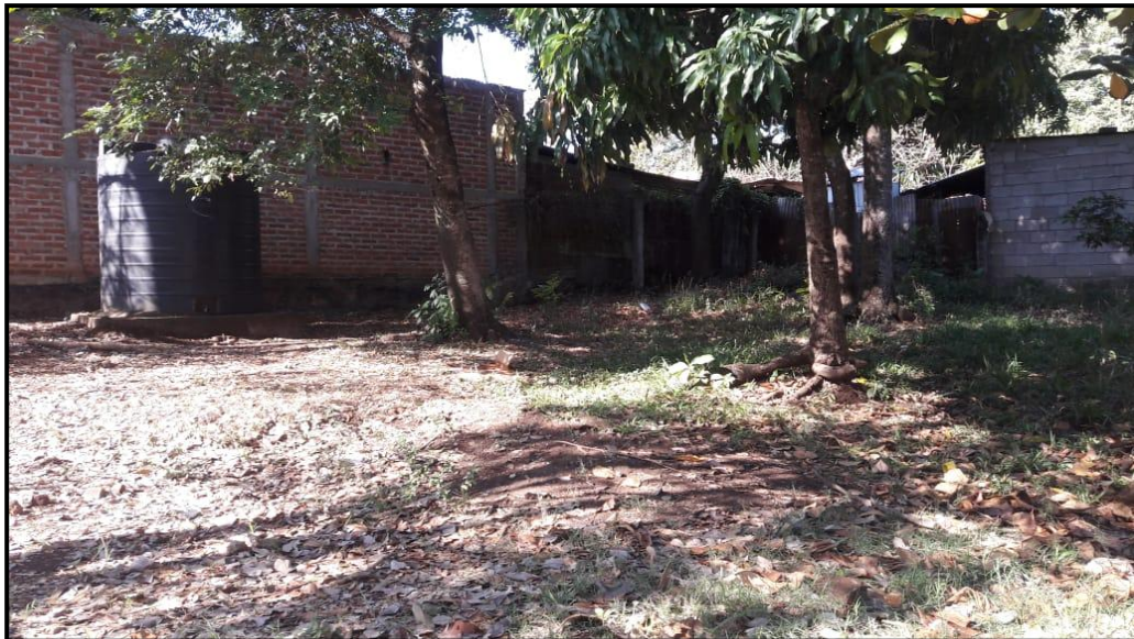
FIGURA 116. ÁREA RECREATIVA EN MAL ESTADO, PARA ESTUDIANTES DE PARVULARIA.
