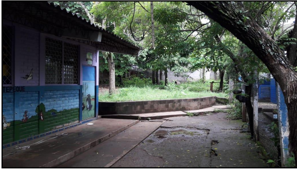
FIGURA 115. PANORÁMICA ACTUAL DEL ÁREA FRENTE A AULAS DE PARVULARIA.
