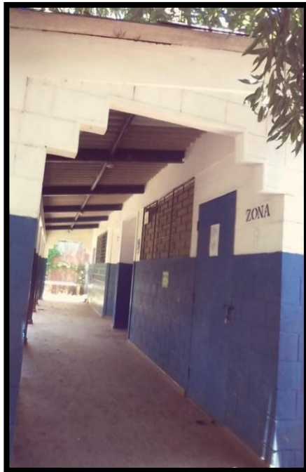
FIGURA 53. PASILLO PRINCIPAL, BLOQUE #6.
