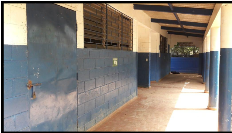
FIGURA 55. PASILLO PRINCIPAL, VISTA 2, BLOQUE #6.
