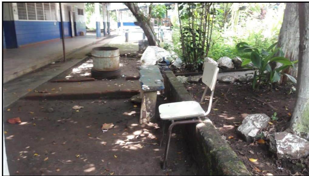
FIGURA 132. ÁREA VERDE DAÑADA FRENTE A BLOQUE #4, ÁREA DONDE SE REALIZARÁ PROPUESTA DE ANTEPROYECTO.
