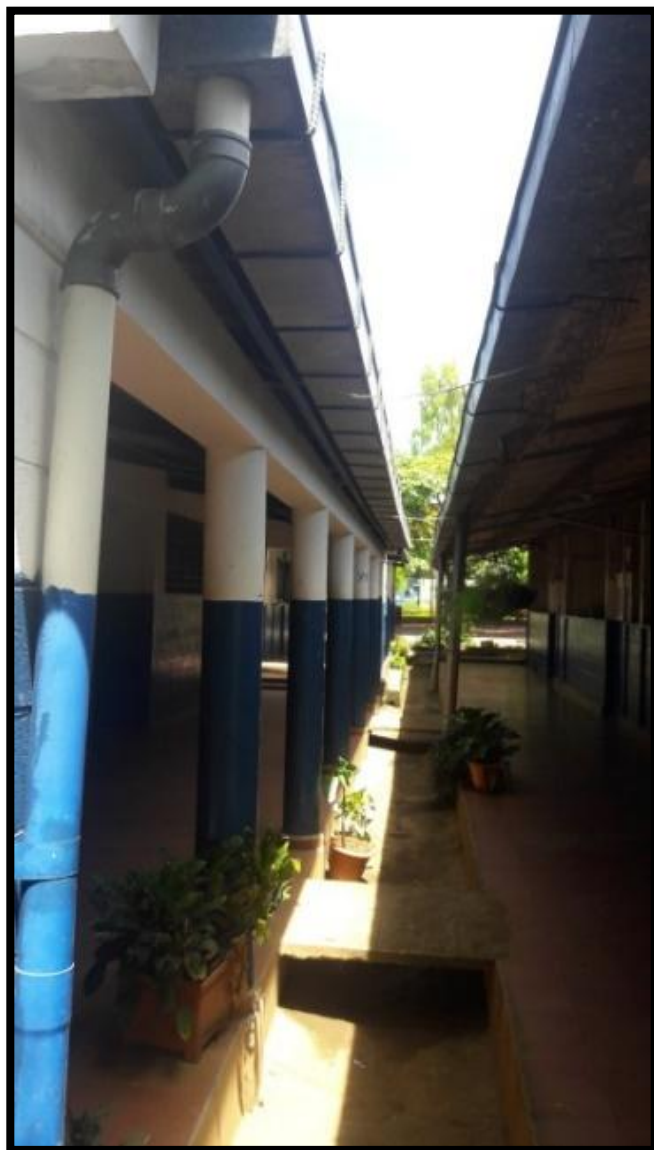
FIGURA 45. PISO INTERIOR EN AULAS, BLOQUE #3.
