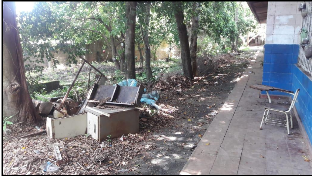
FIGURA 133. VISTA PANORÁMICA DE PARTE TRASERA DE BLOQUE #4, ÁREA DONDE SE REALIZARÁ PROPUESTA DE ANTEPROYECTO.
