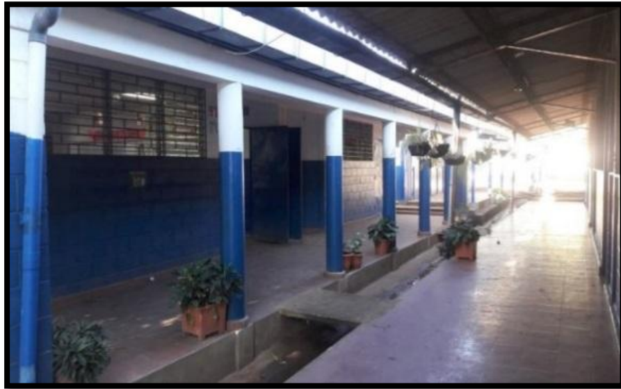
FIGURA 43. VISTA DE PASILLOS DE BLOQUE #2 Y BLOQUE #3.
