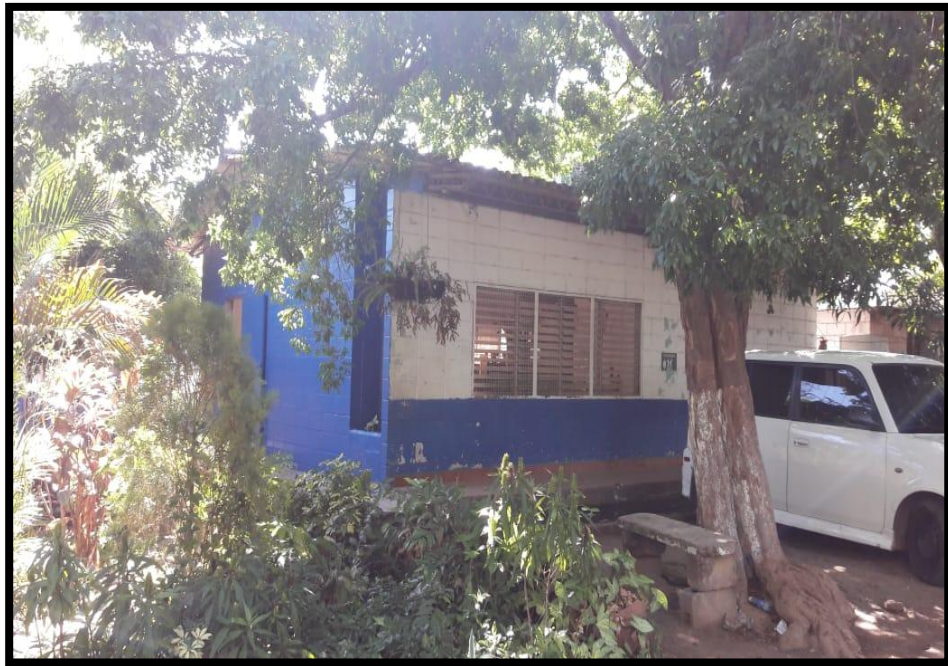
FIGURA 61. VISTA PONIENTE ÁREA DE SECRETARIA.
