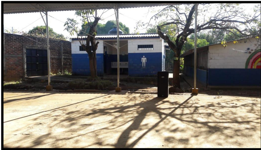
FIGURA 63. FACHADA SUR, BAÑOS PARA SEÑORITA.
