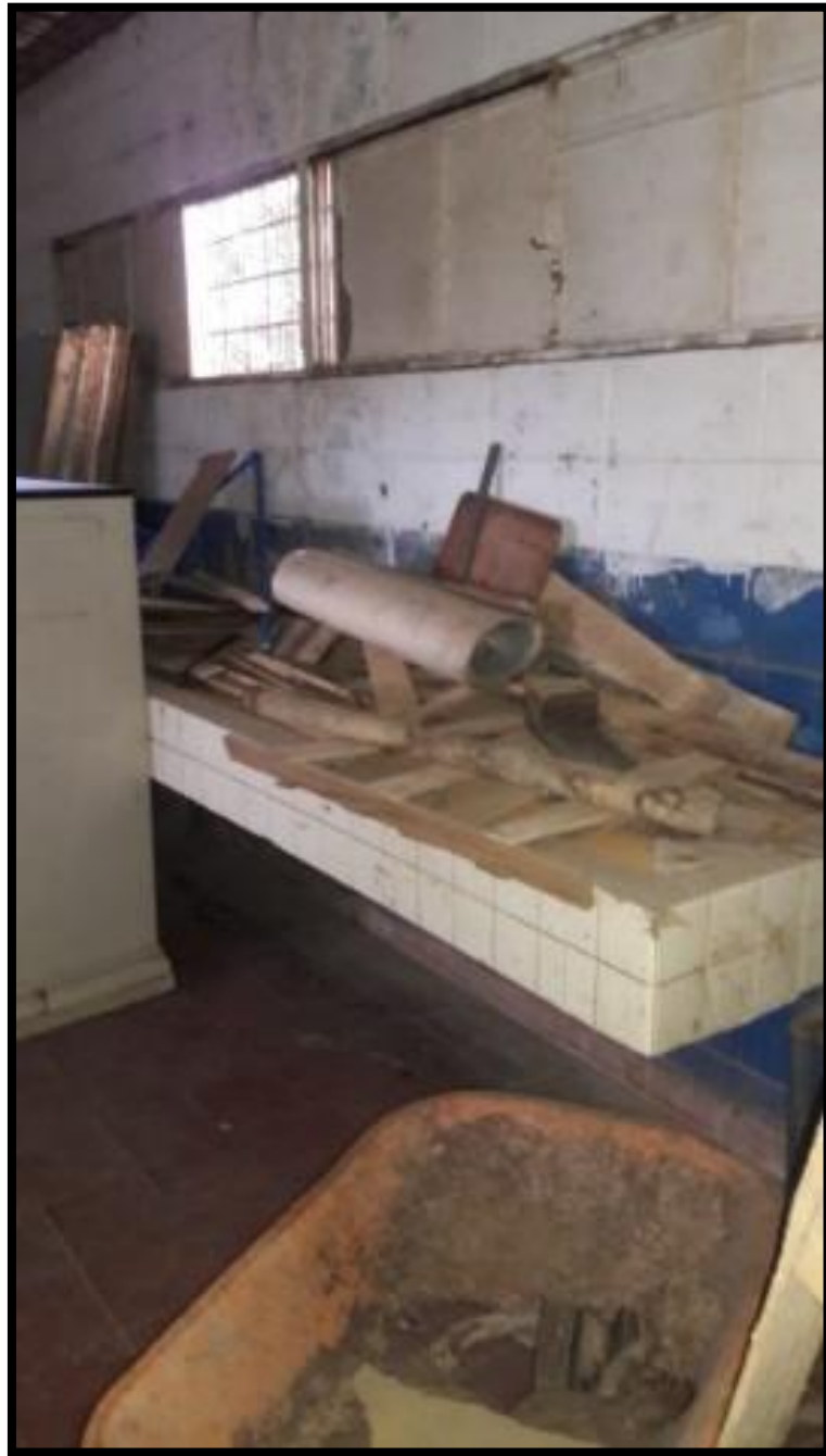
FIGURA 50. AULA DE LABORATORIO ACTUALMENTE USADA COMO BODEGA, BLOQUE #4.
