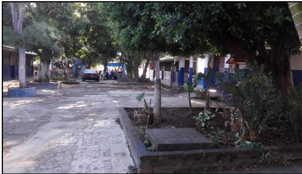
FIGURA 122. ARRIATES EN MAL ESTADO FRENTE ÁREA DE SECRETARIA.
