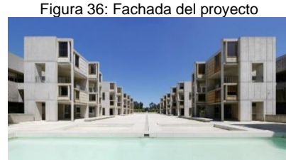
Figura 36: Fachada del proyecto
