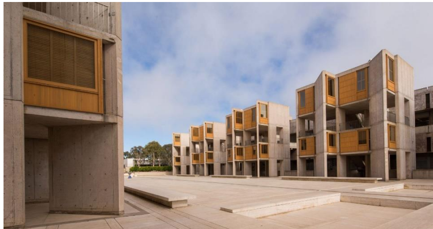
Figura 38: Bloques ortogonales rectangulares agrupados con material de concreto expuesto
