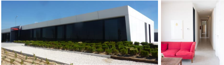
Figura 34: Empleo de fachada de muro cortina y color blanco en todo el proyecto
