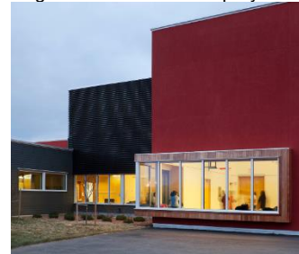
Figura 26: Fachada del proyecto
