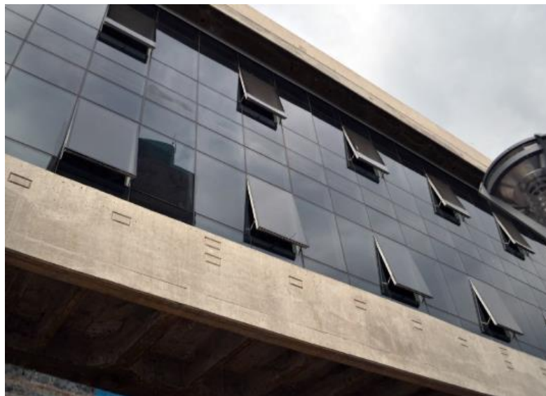
Figura 18: Fachada de muro cortina con concreto expuesto
