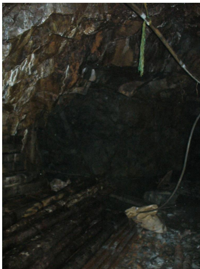
Foto N° 16, Entrada de la Cámara de Bombeo.
