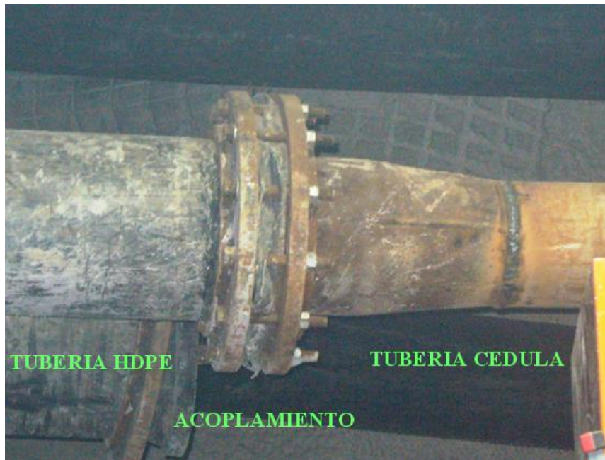
Foto N°4, Acoplamiento de tubería de acero con tubería de HDPE (Minera SIMSA)
