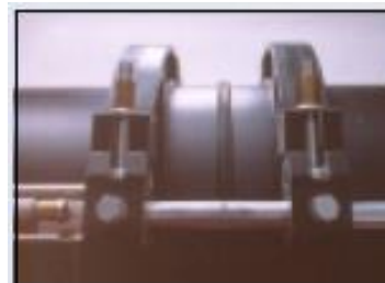
Foto N° 2, Procedimientos de Soldadura por Termofusión.
