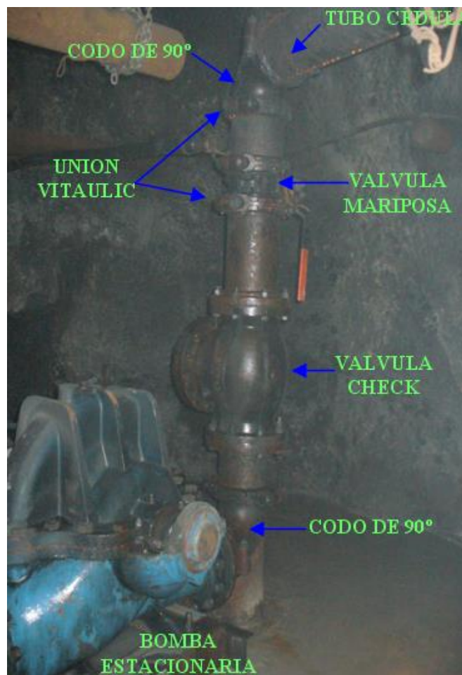
Foto N° 3, Montaje de Bomba Estacionaria (Minera SIMSA)
