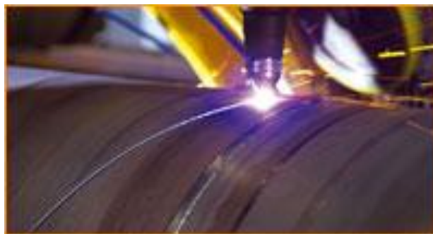
Foto N° 5, Proceso de soldadura Helicoidal
