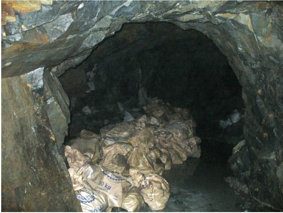
Foto N° 17, Cámara de la Estación de Bombeo en el 5to Nivel.
