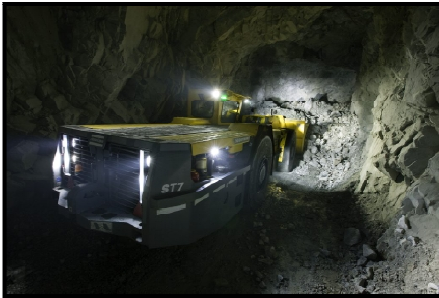
Fig 1.4 Equipo Scooptram, retirando mineral en profundización mina
