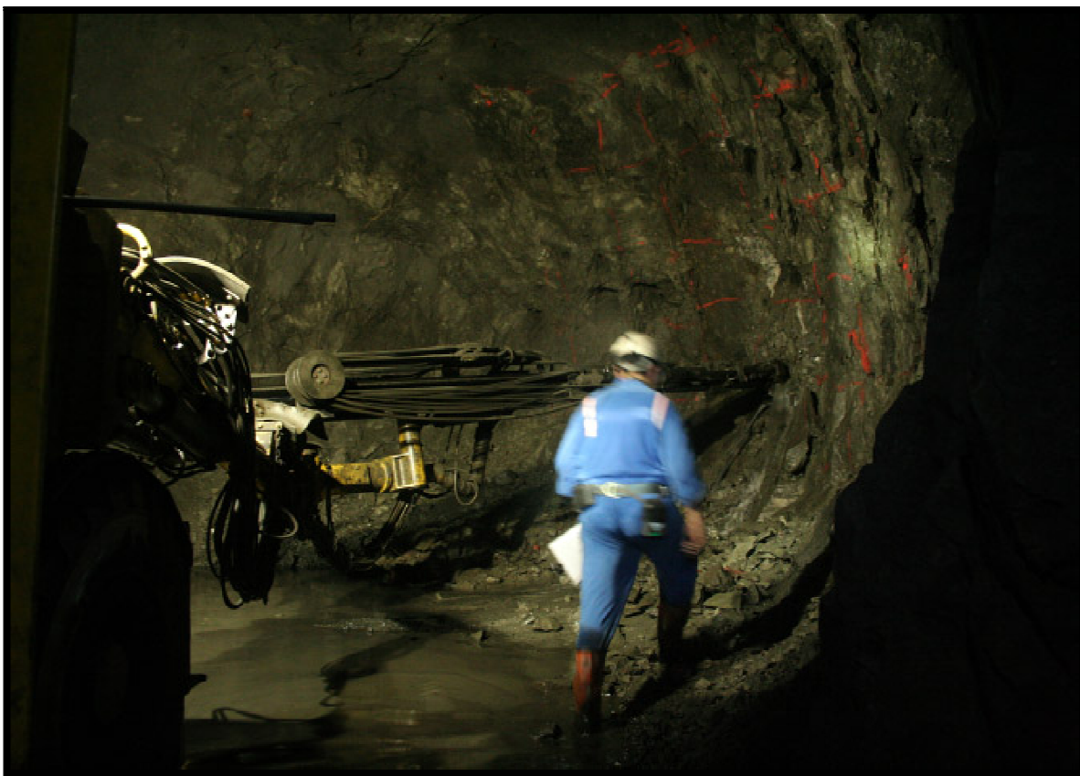
Fig 5.1: Perforación de roca en profundización mina
