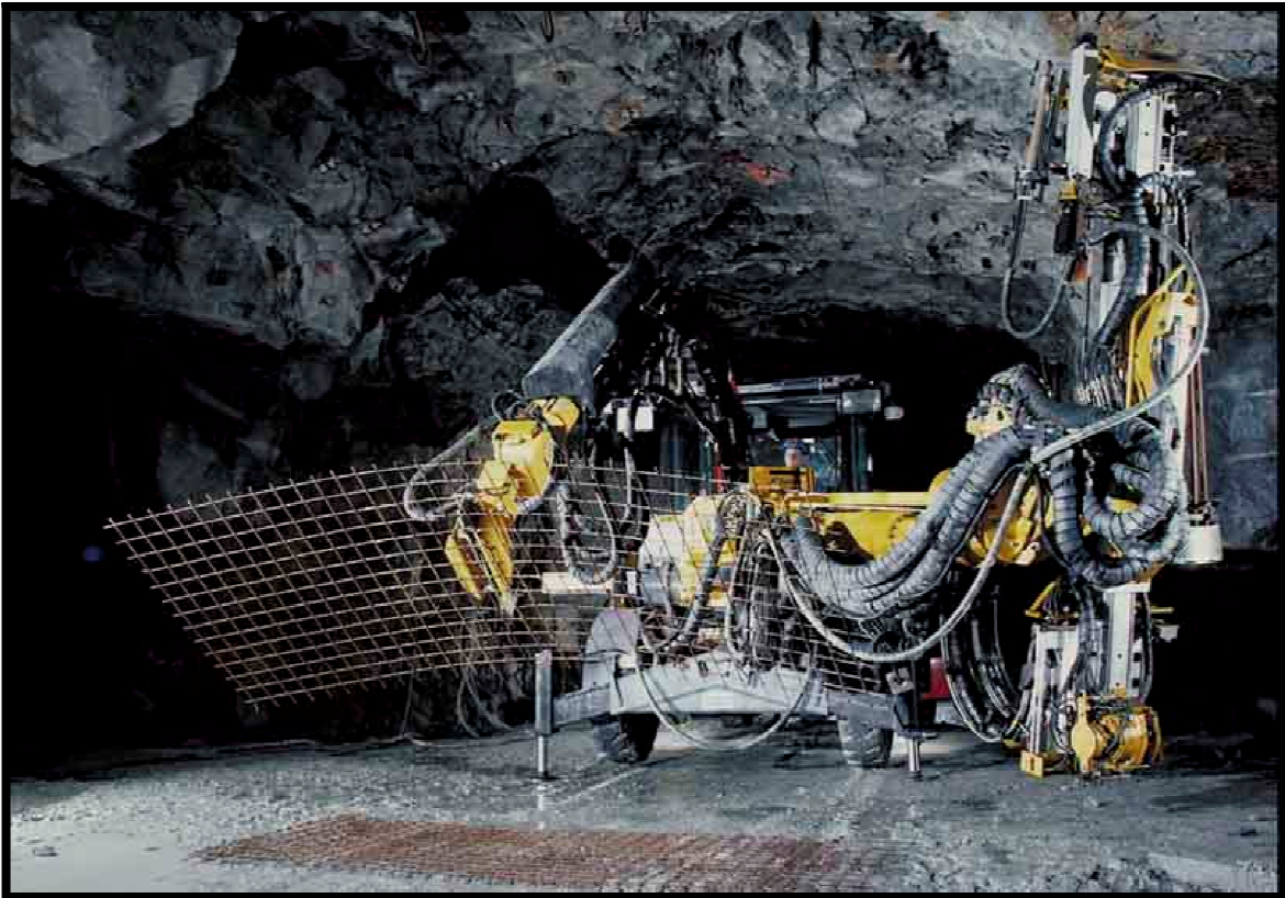
Fig 6.2: Equipo jumbo, realizando trabajo de enmallado y sostenimiento
