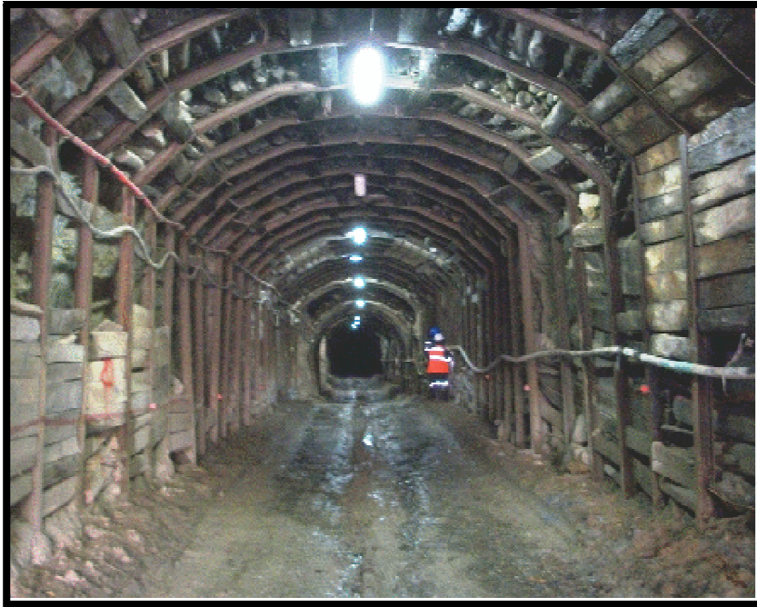
Fig. 1.3: Ingreso a la mina San Genaro
