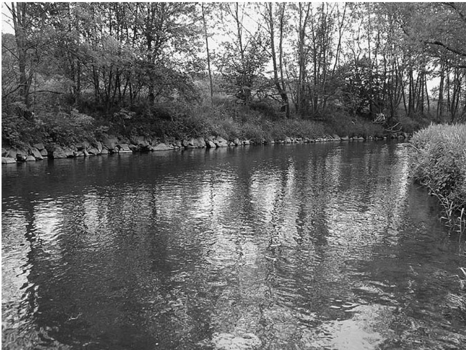
Abb. 2: Ulster-Fluss-Kilometer 10+367, in Fließrichtung, Steinschüttung entlang des linken Ufers (Foto: Johanna Drinnenberg 19.05.2007).
