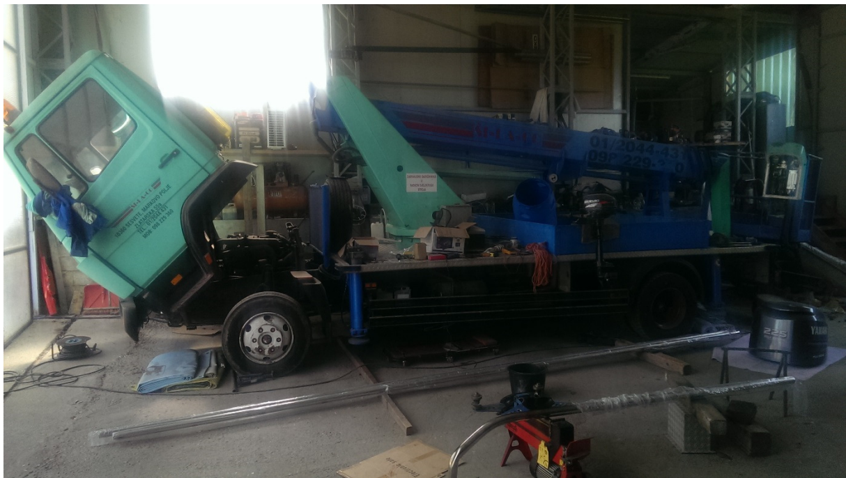
Slika 2. Radovi na radnoj platformi
