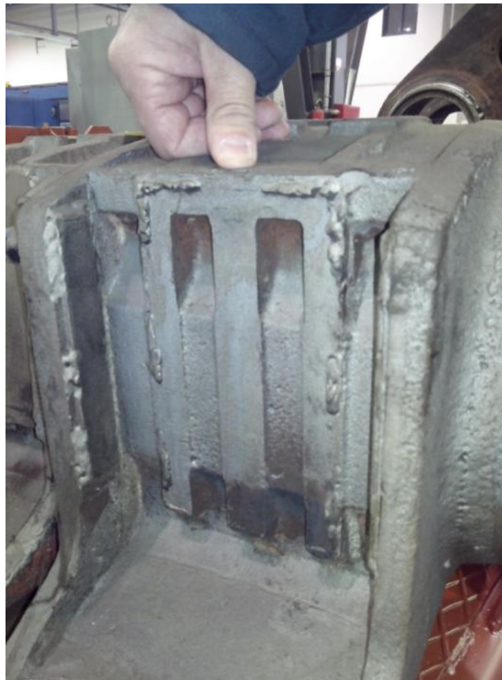
Slika 16. Kućište ležaja na kojem nedostaje manganska ploča ( klizač )
