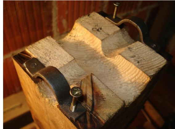
Slika 12. Vrh nosivog stupa sa obujmicama
