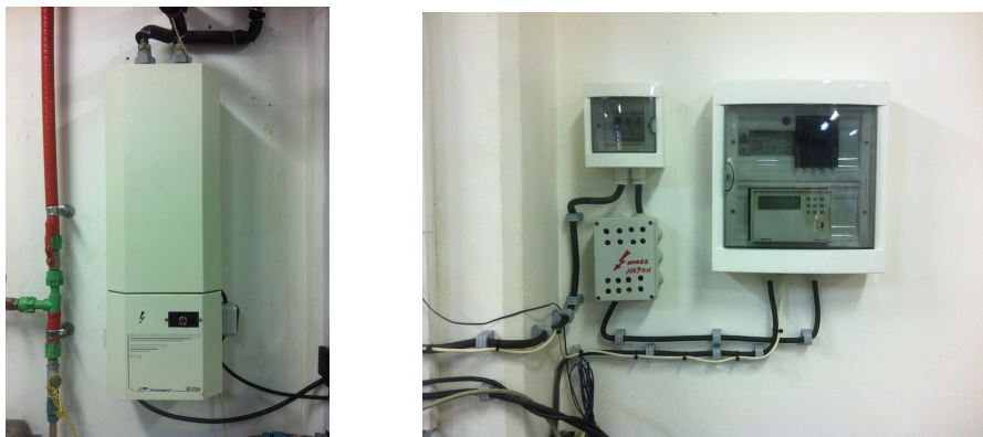
Slika 28. Električni dogrijač s regulacijom
