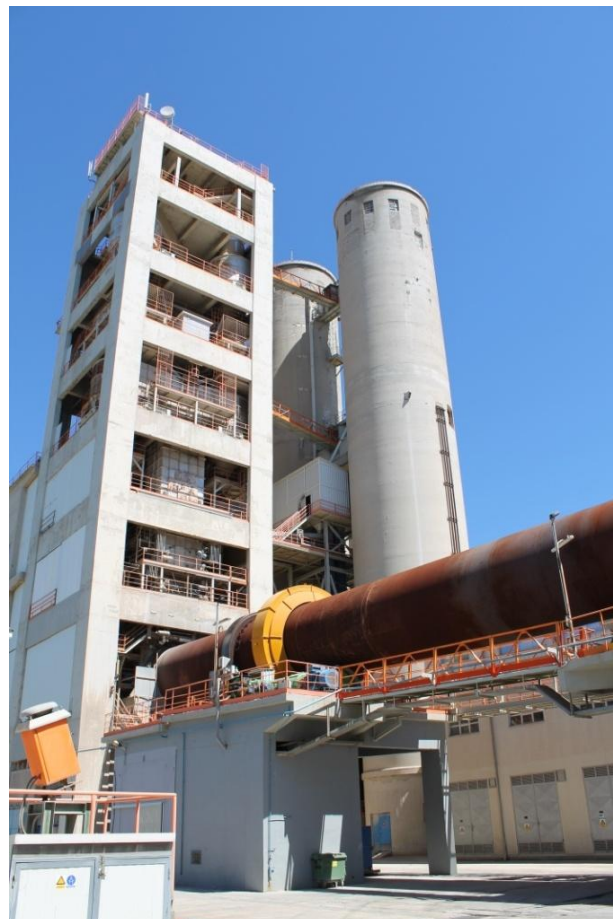
Slika 9. Ciklon i rotacijska peć
