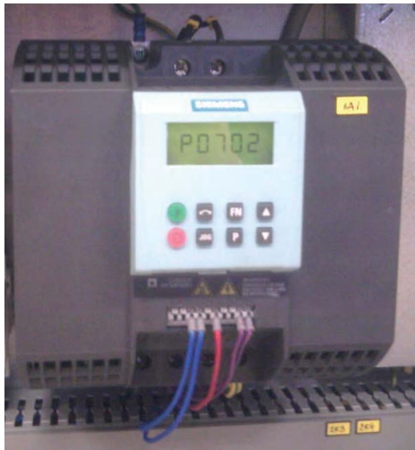
Slika 2.3 Frekvencijski pretvarač Siemens Synamics G-110
