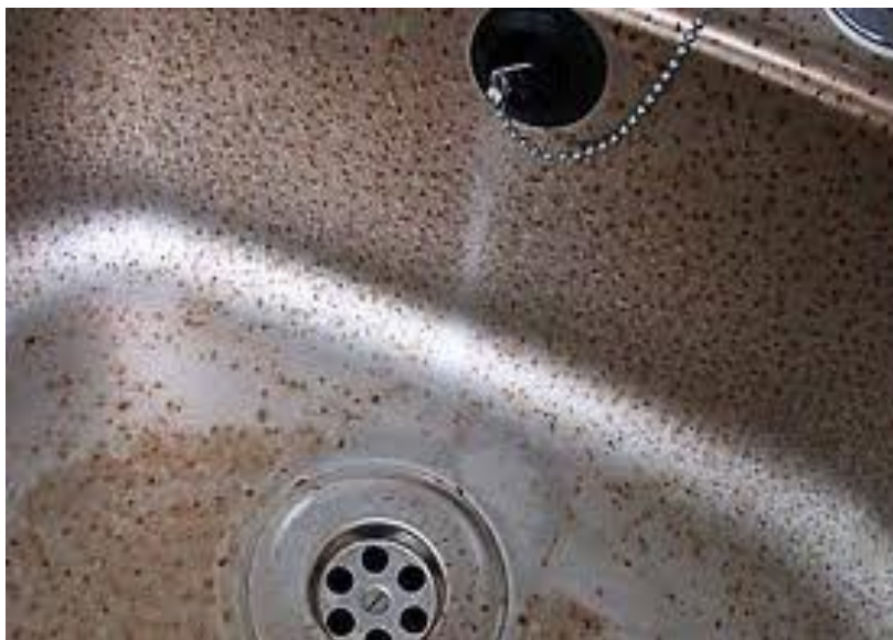
Slika 18. Rupičasta korozija sudopera nakon čišćenja sredstvom koje sadrži kloride [25].
