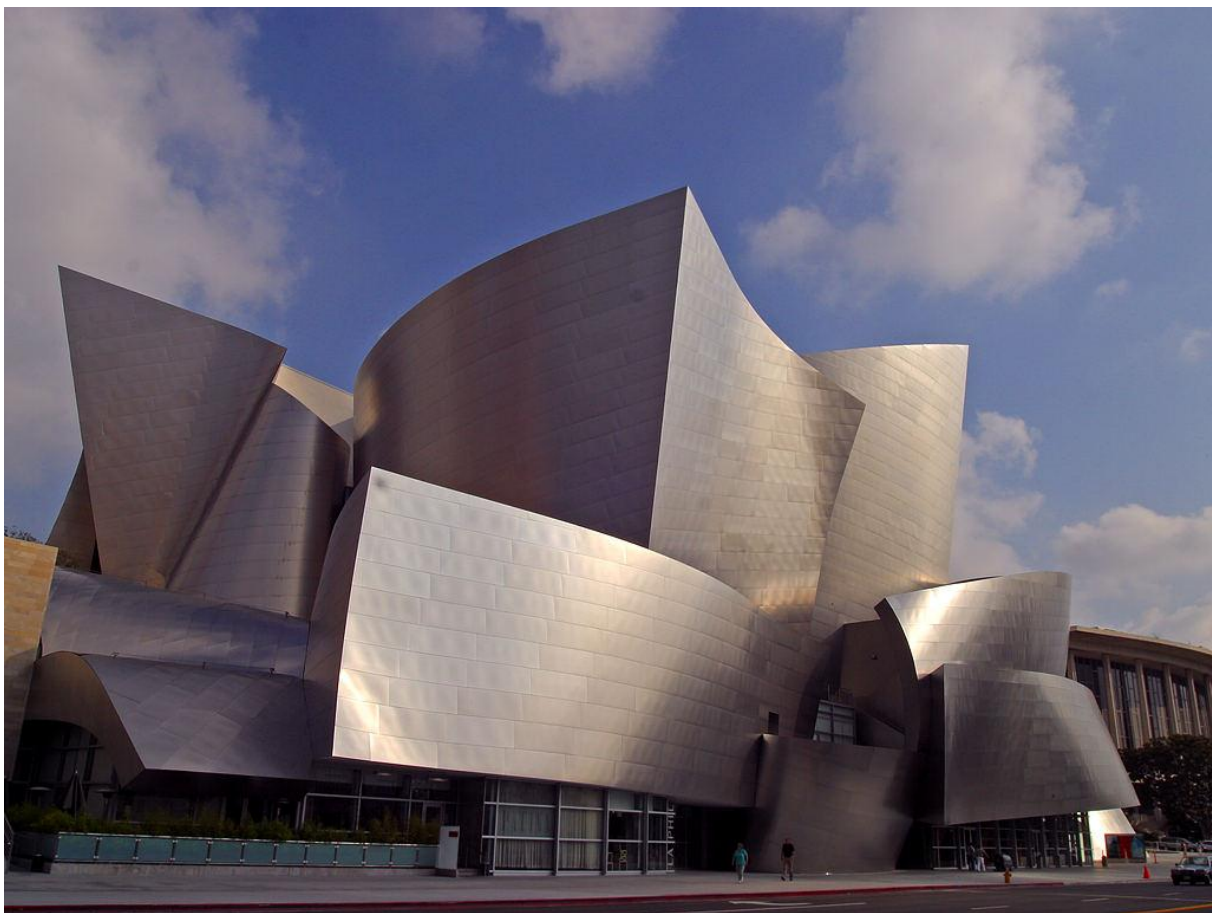
Slika 1. Walt Disney koncertna dvorana u Los Angelesu - obloga fasade od nehrđajućeg čelika [3].
