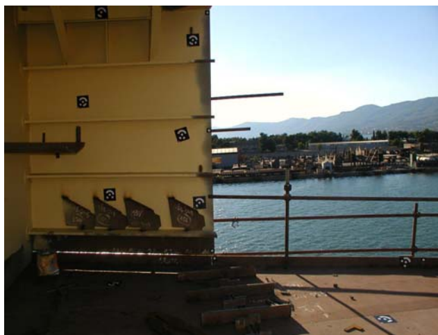
Slika 70: Postavljanje mjernih točaka na navozu
