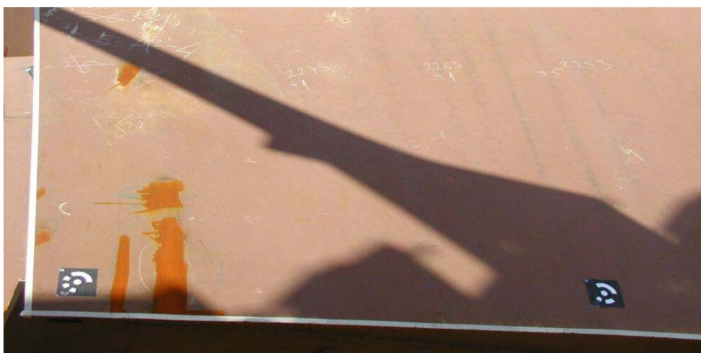
Slika 77: Postavljanje kodiranih mjernih točaka i samoljepljive trake na vanjsku oplatu sekcije
