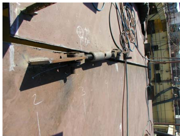
Slika 25: Mehanički pritezač za pozicioniranje sekcije
