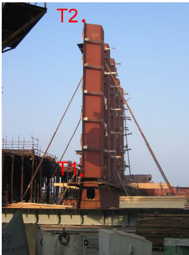
Slika 20: Kontrola okomitosti sekcije uzdužne pregrade
