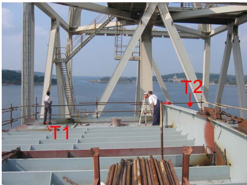
Slika 29: Kontrola uzdužnog nagiba sekcije
