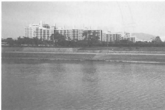
図55 本川の中流，基町高層住宅西
