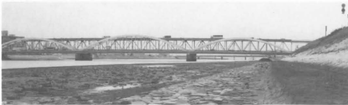
図81 太田川放水路（新己斐橋付近）
