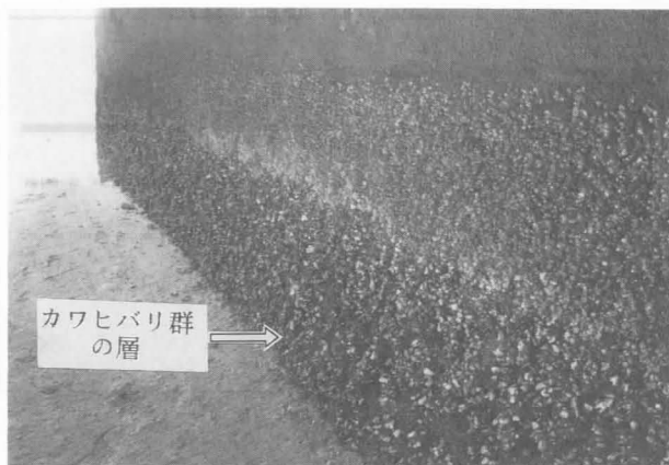
図131 明神橋の橋脚に着生するコウロエンカワヒバリガイの層
