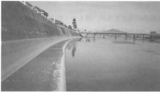
図9 護岸工事の優れた小瀬川
