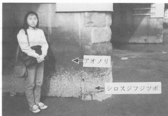
図69 八幡川橋の橋脚
