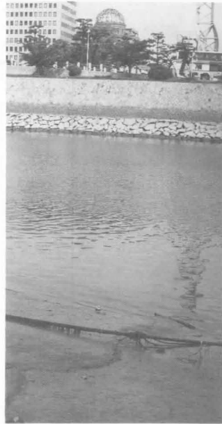
図56 本川相生橋の南（原爆ドーム西） 河川底にヘドロが堆積している。
