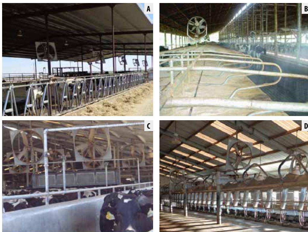
Figura 5. Ventiladores instalados na linha de alimentação (A), nas camas (B), na sala de espera (C) e na sala de ordenha (D).
