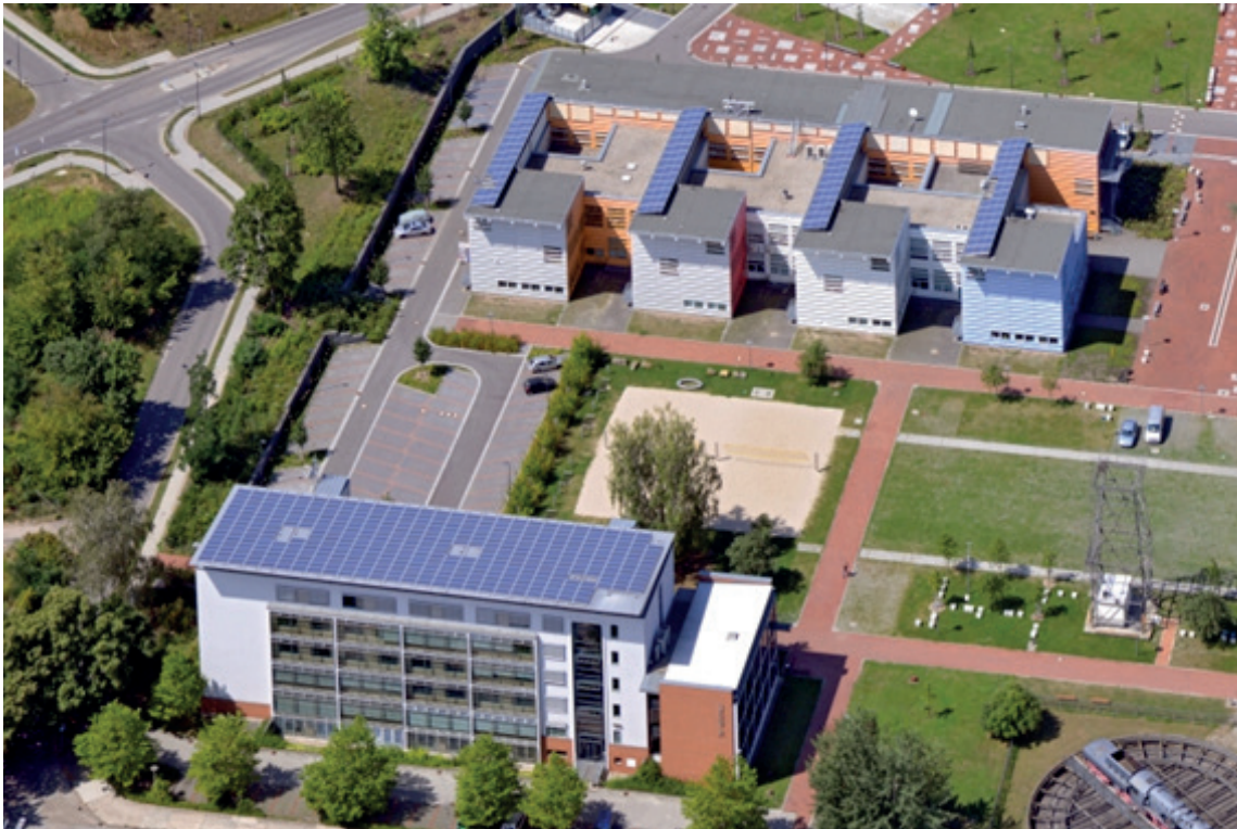
Photovoltaikanlagen auf den Hochschulgebäuden Haus 15 und Haus 100.
