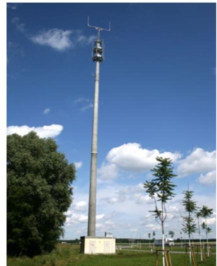
Abb. 1) Foto eines Digitalfunkmasts mit zugehörigem Systemtechnik-Container
