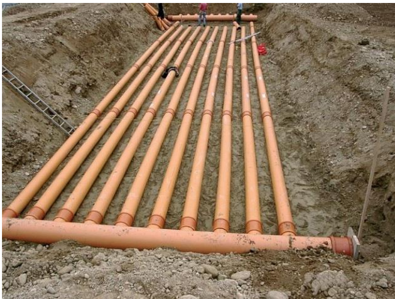
Рисунок 3.1 – Труби для збирання підземного тепла/прохолоди (Закопана, 2015)
