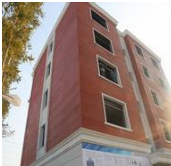
Рисунок 4.2 – Будинки, надруковані на 3D-принтері Шанхайською компанією WinSun (Шанхайская, 2015)
