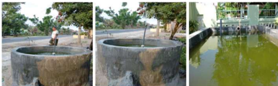
Gambar 11.13 Pembuatan kolam dari terpal plastik dan sumur/bis beton
