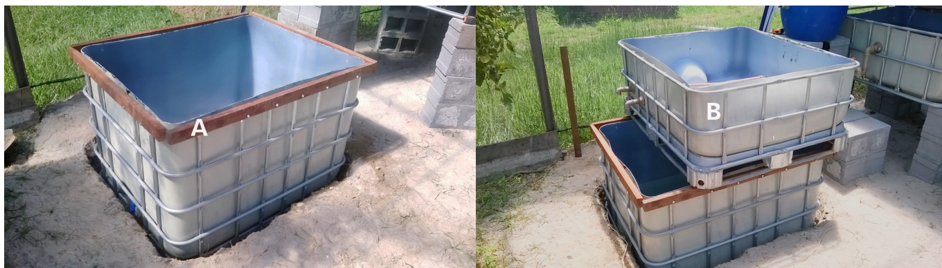
Figura 5. Caixa de contenção dos peixes após pintura (com camada de tinta de colocação clara sobre camada de tinta preta) instalada a 30 cm abaixo da superfície do solo. (A) Detalhe do reforço com barras de madeira parafusadas na estrutura metálica para sustentar o peso da (B) caixa de cultivo de raízes tuberosas em areia.
