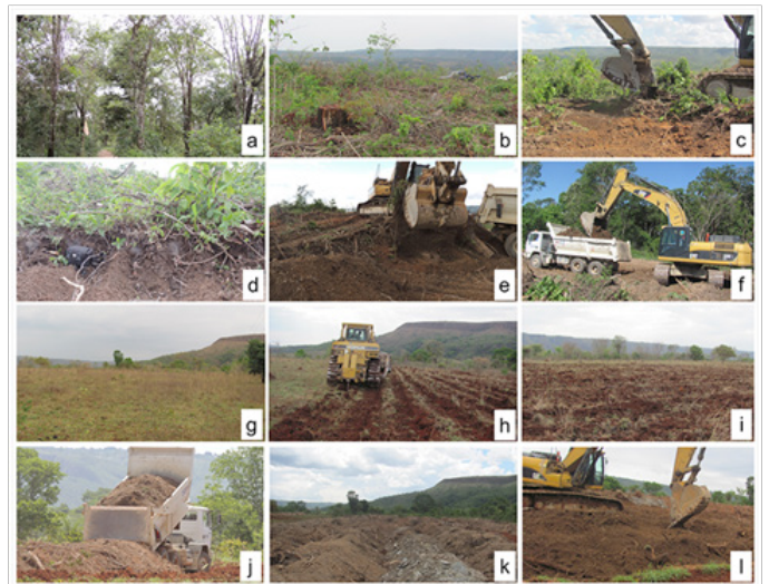
Figura 2. Etapas da transposição da camada superficial do solo (CSS) de Floresta Estacional Decidual, Região da Fercal, Distrito Federal, Brasil. a: floresta antes da supressão; b: floresta após a supressão; c: remoção da CSS por uma retroescavadeira; d: superfície de solo removida, 30 cm; e: pilha de solo com serrapilheira, fragmentos de raiz, caule, plantas inteiras e sementes; f: retroescavadeira dispendo o solo no caminho; g: a área de deposição era uma pastagem com baixa regeneração natural; h: área de deposição escarificada por um trator esteira; i: solo descompactado e livre da dominância de gramíneas; j: deposição da CSS; k: superfície da área de deposição; l: retroescavadeira nivelando a CSS na espessura de 20 cm.
