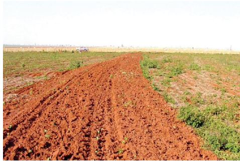
Figura 5. Terraço de base larga utilizado para redução das limitações por susceptibilidade à erosão em solos de textura média em relevo suave ondulado.
