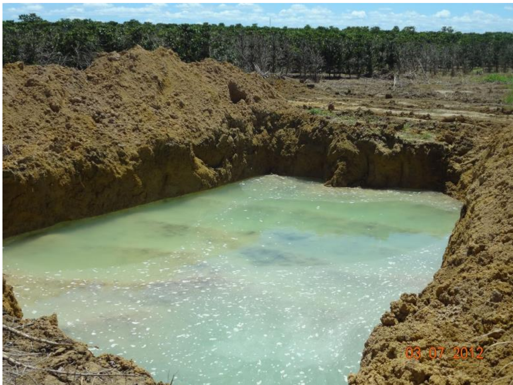
Figura 19. Escavação no terreno com o propósito de servir para depósito das águas de drenagem em local vizinho à área de estudo, correspondente à unidade CXbe3.
