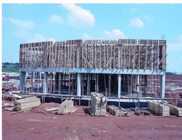
Fig. 1: Cerca de 1,5 hectare foram terraplanados e as estruturas de concreto armado estão sendo erguidas.
