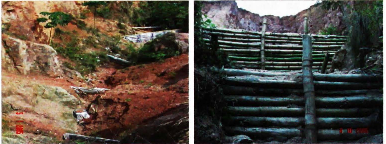
Figura 5: Paliçadas de bambu implantadas na área interna da voçoroca.
