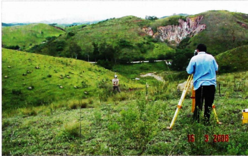
Figura 11: Locação de terraços com nível óptico.
