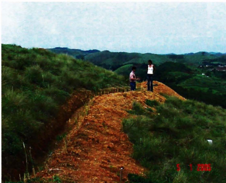
Figura 3: Vista de um terraço de base estreita do tipo “cordão em contorno”, município de Pinheiral-RJ. A terra retirada é colocada abaixo do terraço, formando um camalhão para aumentar sua eficiência.
