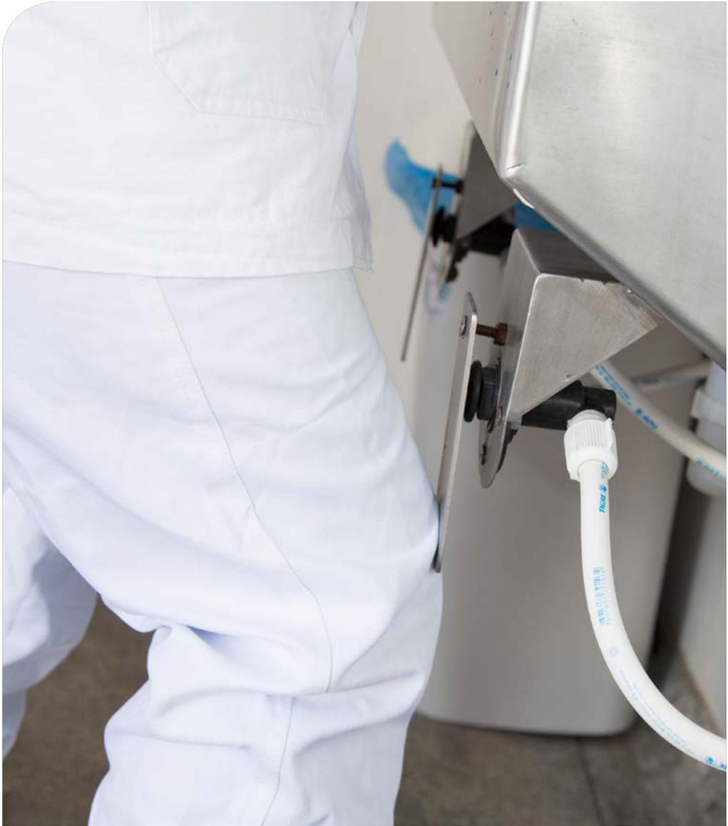
**Figura 3.** Torneira do bloqueio sanitário com acionamento automático (joelho), sem contato manual.
