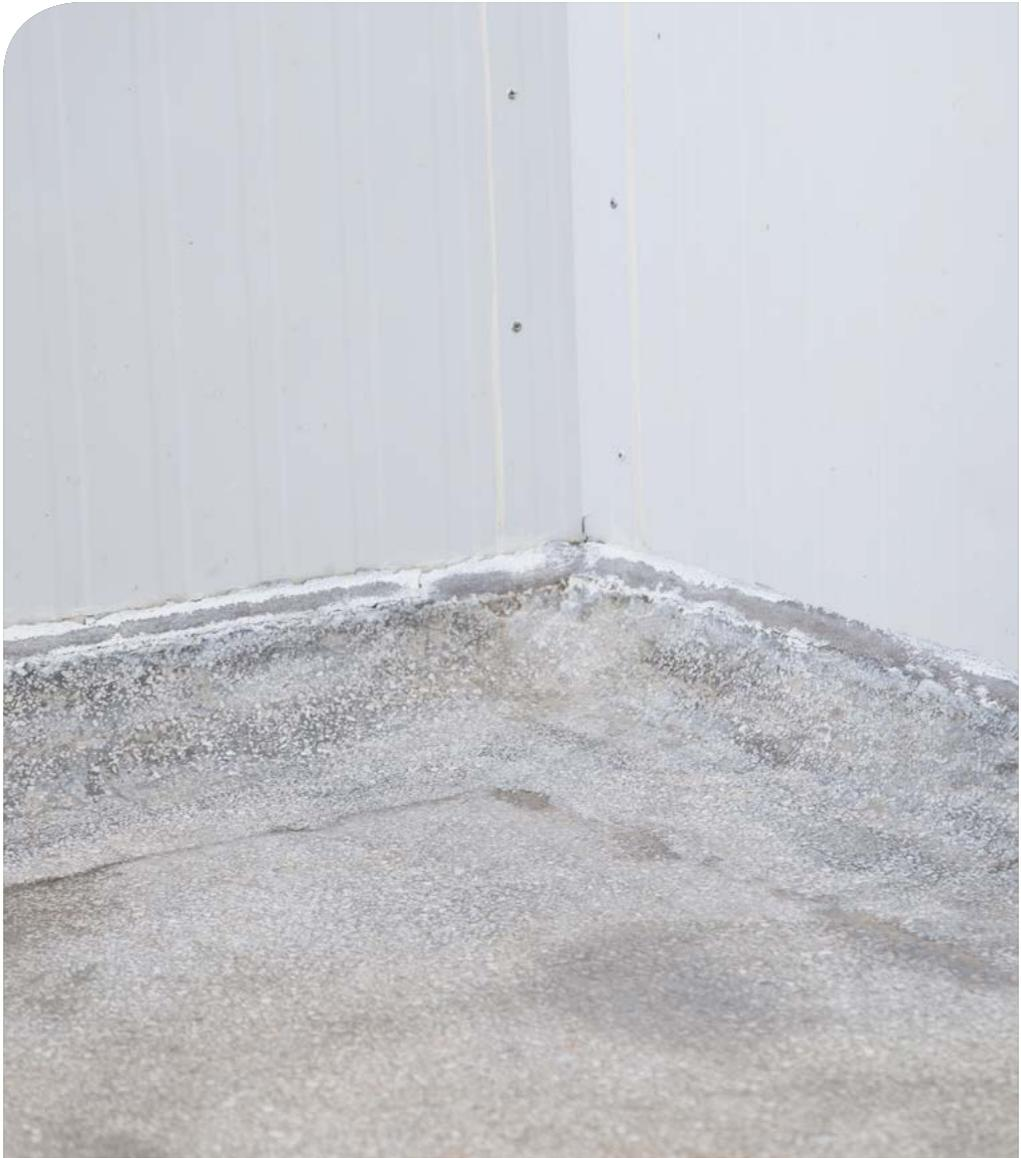
**Figura 5.** Cantos dos rodapés arredondados. Evita o acúmulo de sujeira e facilita a higienização.
