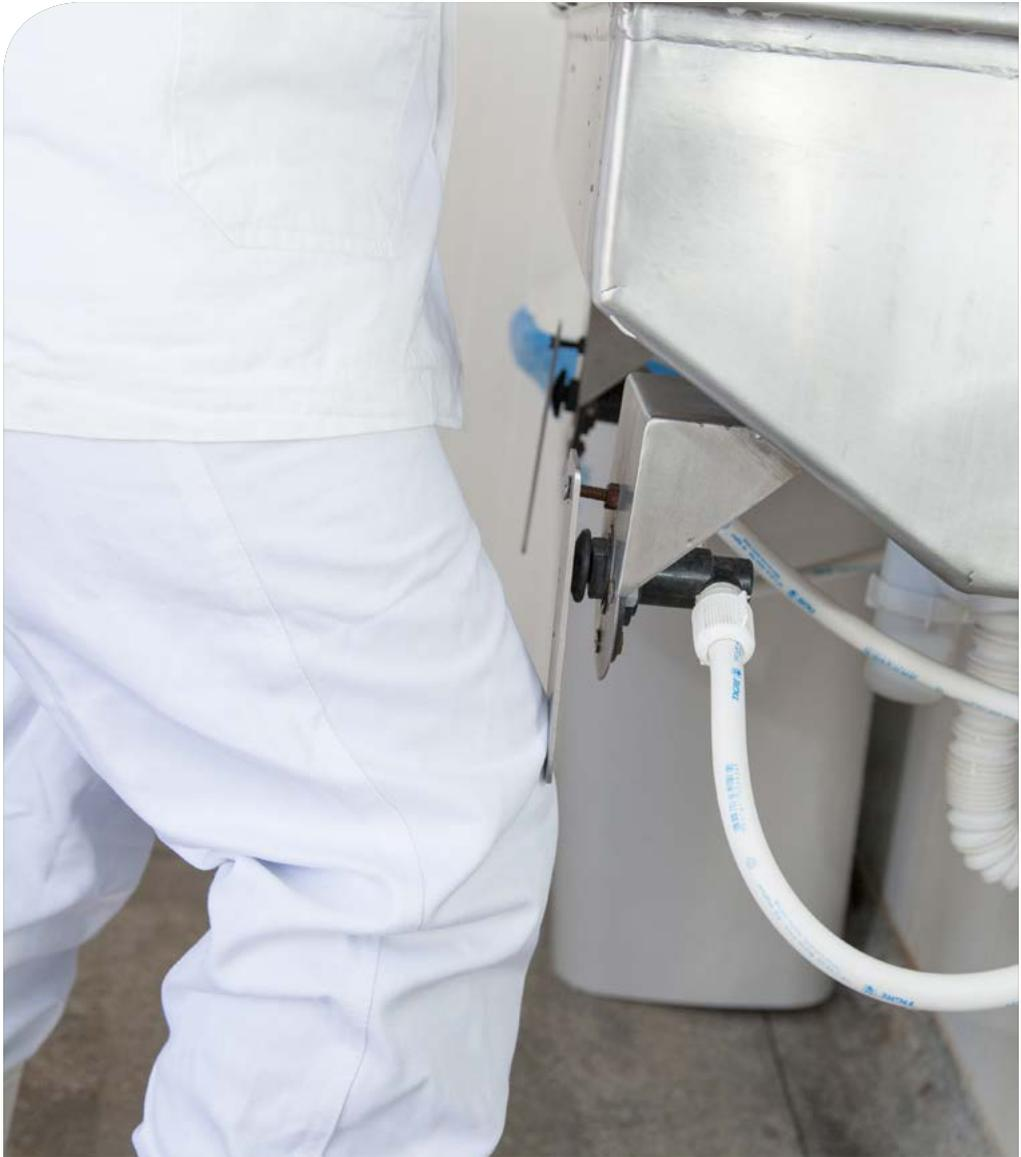
Figura 20. Acionamento da torneira sem contato manual.
