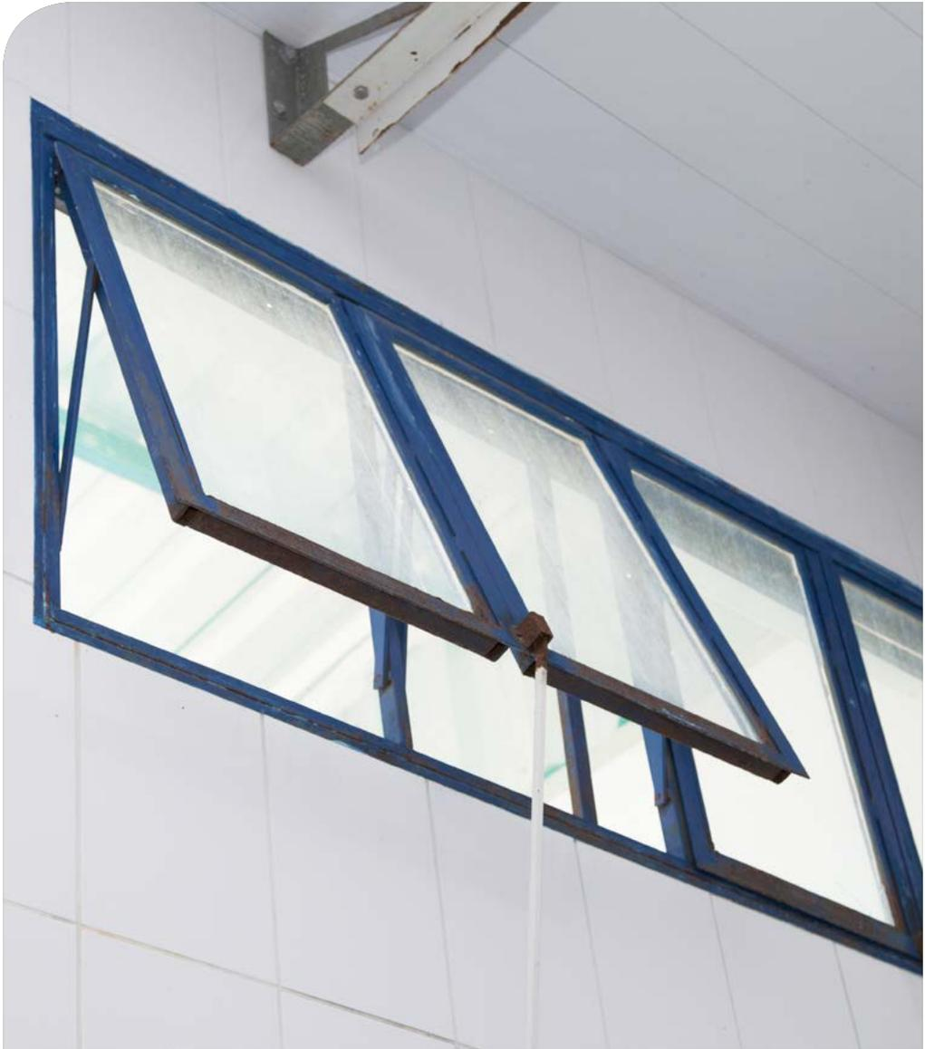
**Figura 1.** Vestiário com paredes e teto revestidos de material impermeável. Janela telada.
