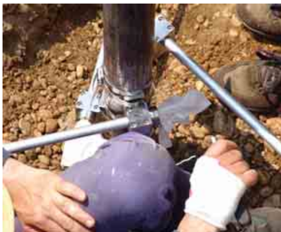
Abb. 4-6: Am mittleren Rohr R1 vormontierte Adapter
