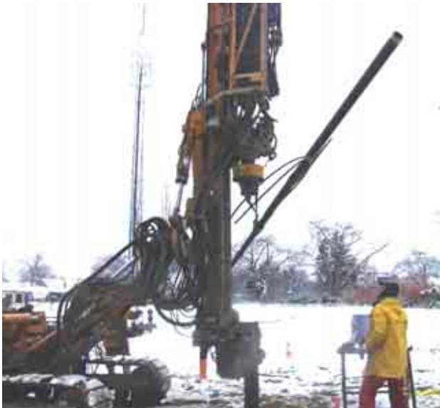
Abb. 4-4: Einsetzen des Ventilrohres
