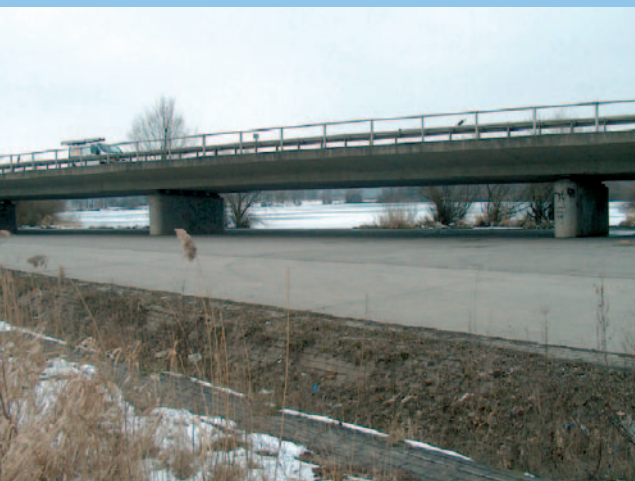
Abb. 11: Aufständerung einer Brücke zur Reduzierung des Hochwasserrückstaus (Quelle: NLWKN 2005: 23)
