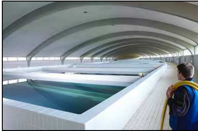
Abbildung 2: Sandschnellfilterbecken
