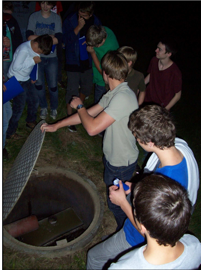
Abbildung 4: Untersuchung des Zuflusses der Schilfkläranlage im Jugendwaldheim Bayersicher Wald
